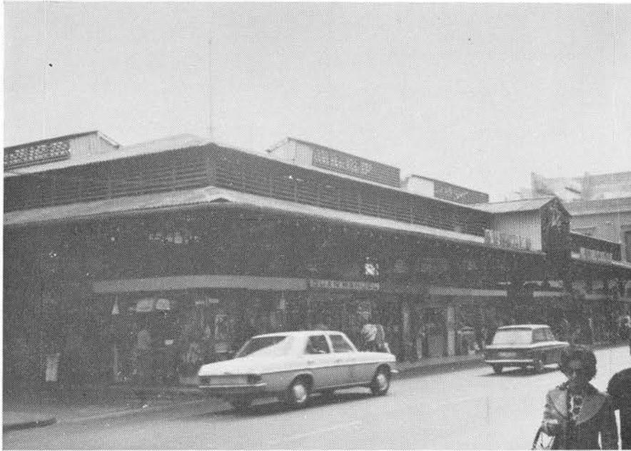
Fig. 2.—Mercado Municipal en la zona del puerto de Las Palmas, única realización en hierro existente en las islas hacia 1880.
