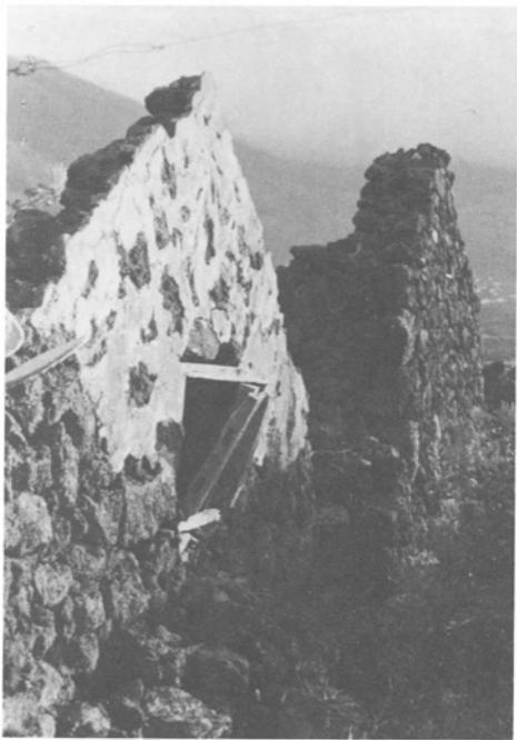
Detalle de las viviendas del caserío. (Foto M.C. Jiménez)
