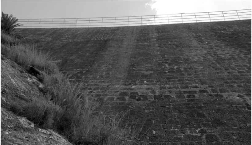
Detalle de la margen derecha de la presa
