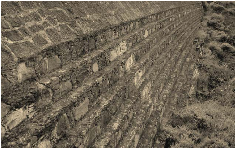
Talud aguas abajo de la Presa de San Lorenzo (Foto Jaime González) (Cuerpo del Muro: mampostería ordinaria )
