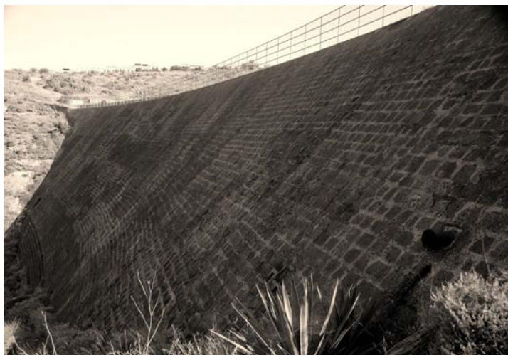
Presa de Martínón (Foto Jaime González)
