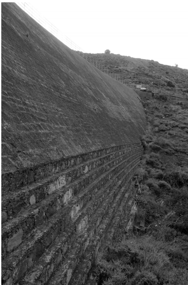
Detalle del recrecido sobre el talud escalonado de la presa primitiva (Foto J. Palomo)
