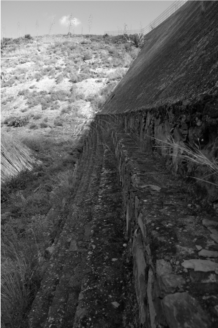
Vista del muro antiguo y del recrecio de la Presa de Martínón (Foto J. Palomo)
