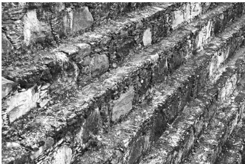
Detalle del escalonado del muro antiguo de la Presa de San Lorenzo (Foto J. Palomo)
