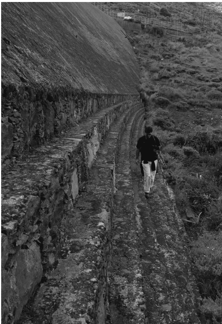
Caminando por el talud escalonado de la antigua Presa de San Lorenzo
