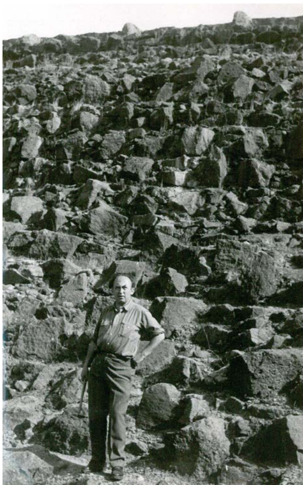
La foto del Ingeniero de Caminos don José Luis Fernández Casado en la antigua Presa de San Lorenzo (1964) muestra el paramento de agua abajo rugoso con sus mampuestos salientes (Foto Servicio de Vigilancia de Presas)
