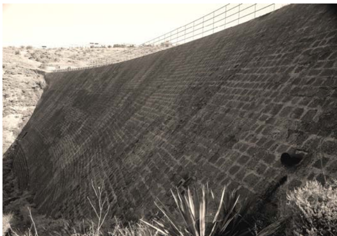
Presa de Martínón (Foto Jaime González)
