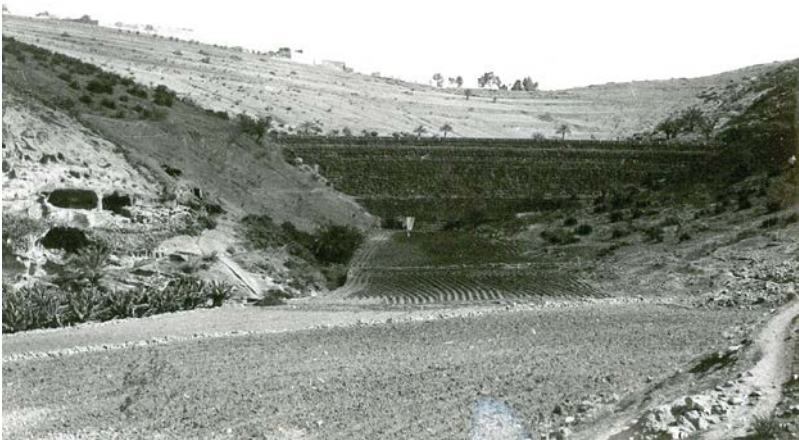
Presa de Martínón - 1964 (Foto Vigilancia de Presas)
