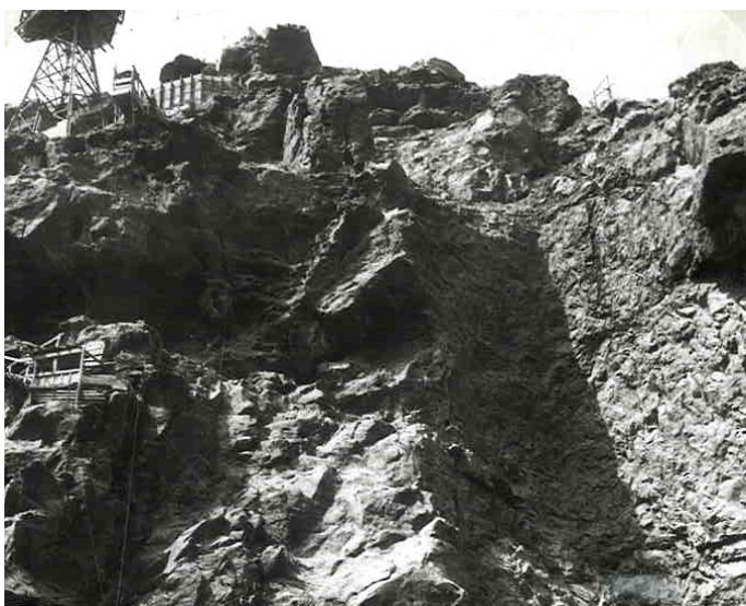
Excavación del estribo derecho
