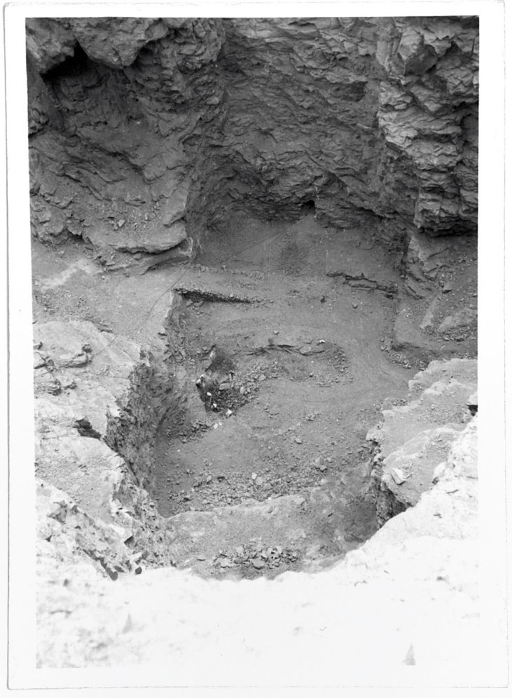
excavación correspondiente al zócalo o tapón de fondo Año 1963 (se observa la entrada de la galería en roca) (Foto Comunidad La Lumbre)
