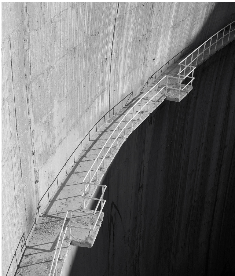
La pasarela. Presa de Soria. (Foto Jaime González)
