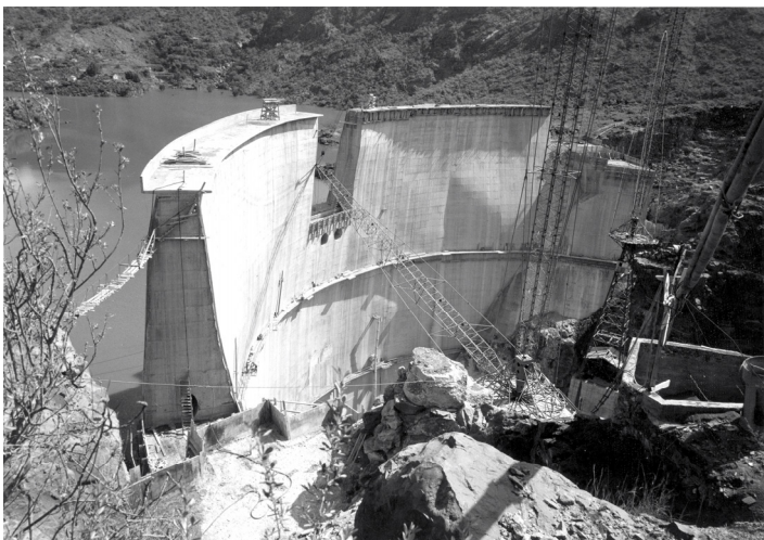
Hay ya bloques en cota de coronación 1971- (Foto Vigilancia de Presas)
