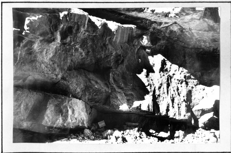
④ ASPECTO DE LAS DIACLASAS EN LOS FRENTES DE EXCAVACION.
