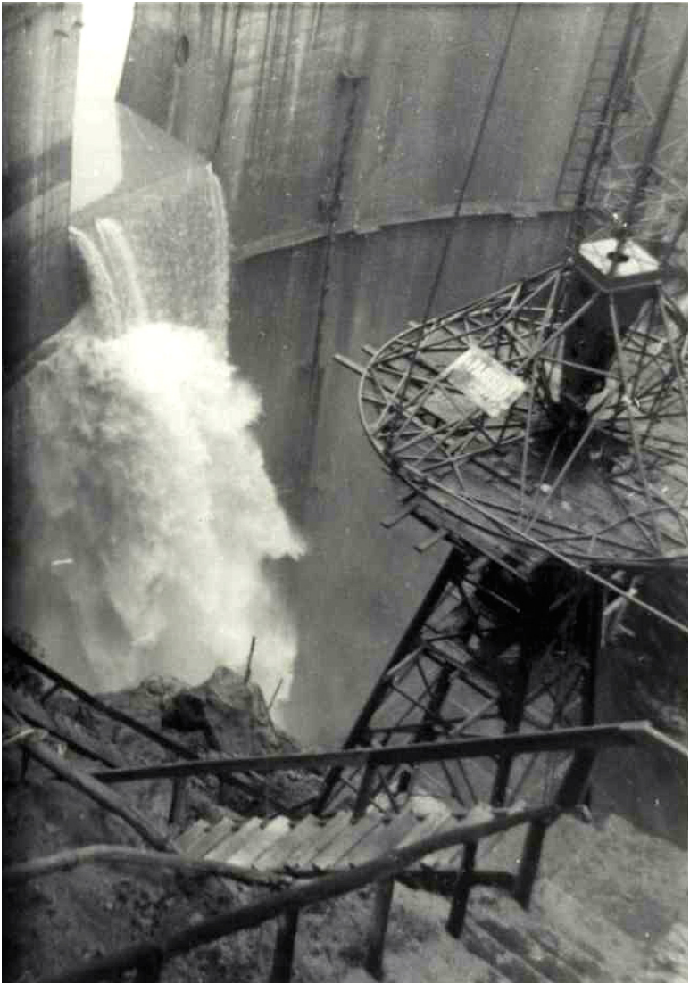
El embalse rebozó por el punto más bajo de la presa (573,50) (Foto Vigilancia de Presas)
