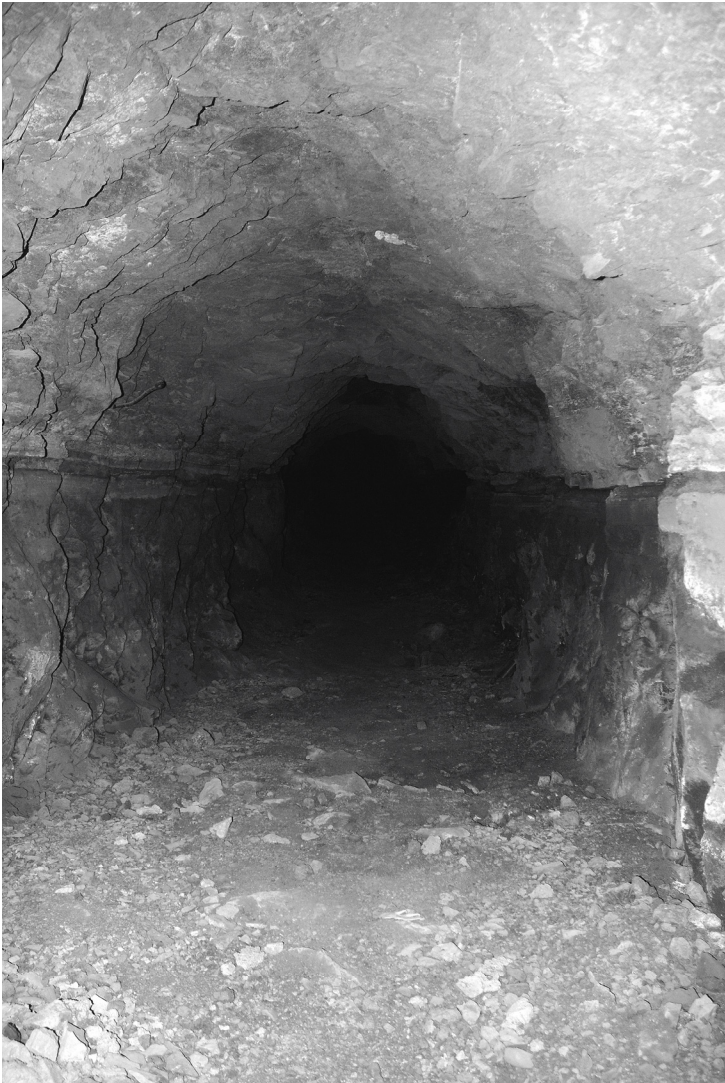
Galería en roca con diaclasas (estribo derecho, cota 602,25) (Foto Jaime González)
