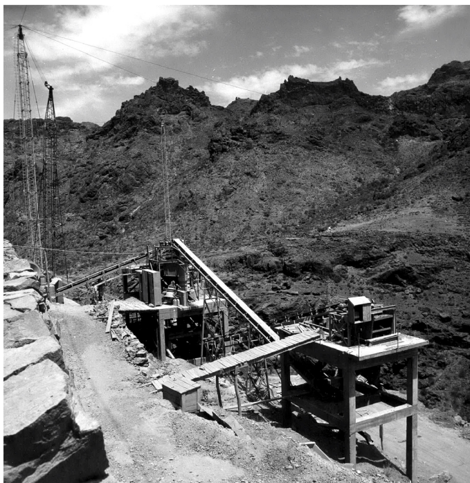
Estación de machaqueo de áridos (Foto cedida por la familia de don Fermín Monzón)
