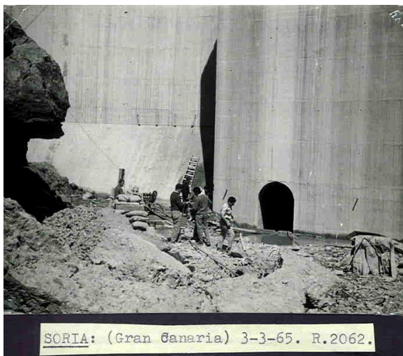
Entrada a la galería baja (Vigilancia de Presas)
