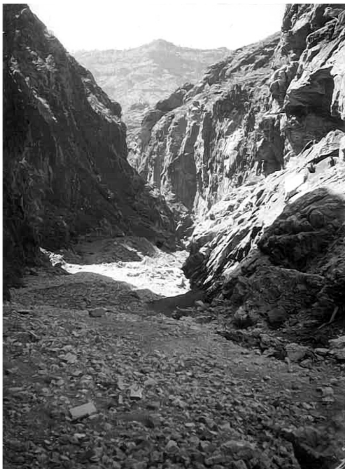
Escombros en el cauce producto de la demolición del hormigón ejecutado en el cuerpo de la presa (Foto Vigilancia de Presas)
