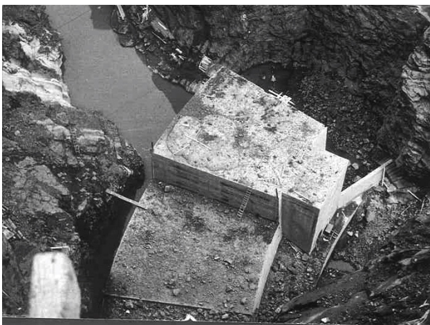
R.1354. Presa del Barranco de Soria . Tapón de fondo y bloque central. 11-1-64 (GRAN CAÑARIA)
