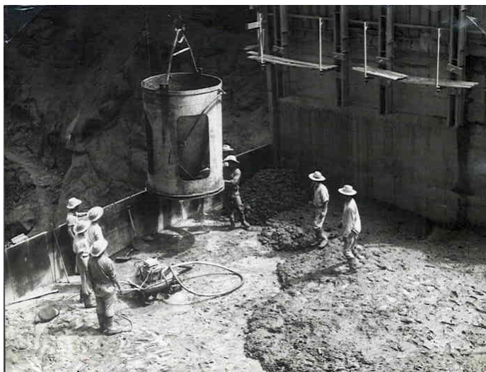
Hormigonado de un bloque con el cacharrón (Fotos Vigilancia de Presas)
