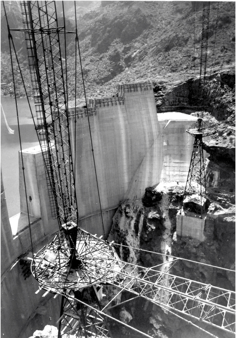
Detalle de las grúas Derrick y los tajos de la bóveda (Foto Servicio Hidráulico de Las Palmas)
