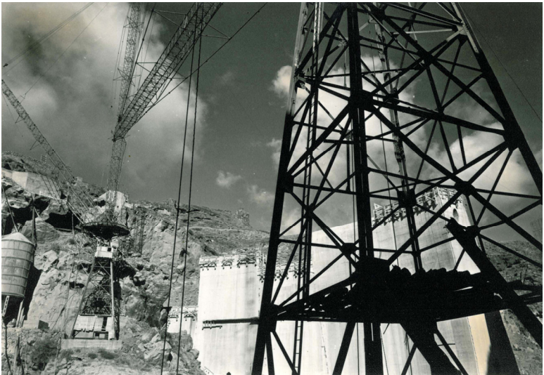
La Presa de Soria en 1968 - 1969 (Fotos Servicio Hidráulico de Las Palmas)
