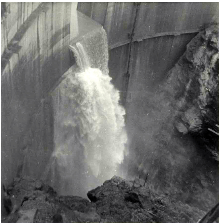
(1968 – 1969) año hidráulico de abundante precipitación Terreno, obra y agua (Foto Vigilancia de Presas)
