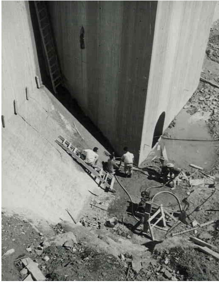
Inyección de juntas
