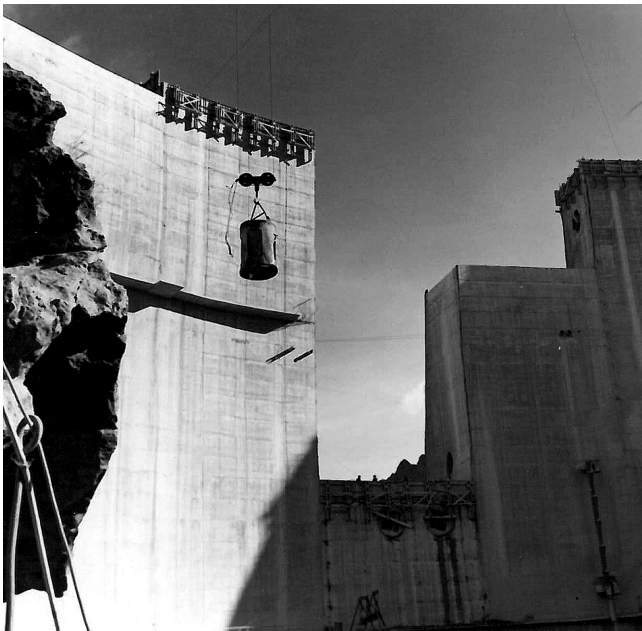
Detalle del hormigonado de la bóveda con el cacharrón (Foto Servicio Hidráulico de Las Palmas)
