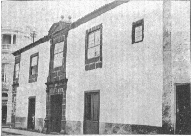
Lám. VIII. – La Laguna. Antigua casa de la familia Calderín (hoy reedificada por su actual propietario). Fot. G. Rivero.
