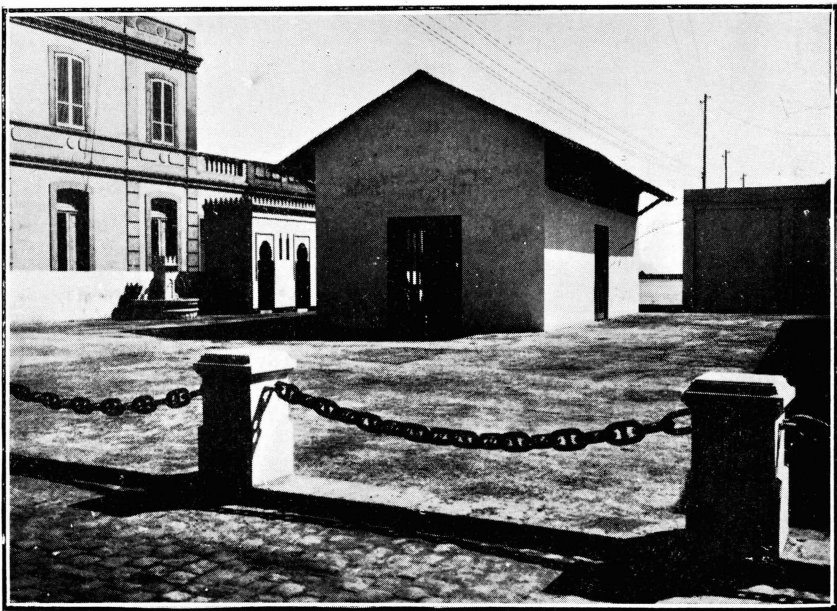
XXVIII.—Nueva explanada, tinglado y retrete en el arranque del muelle de Santa Catalina.
