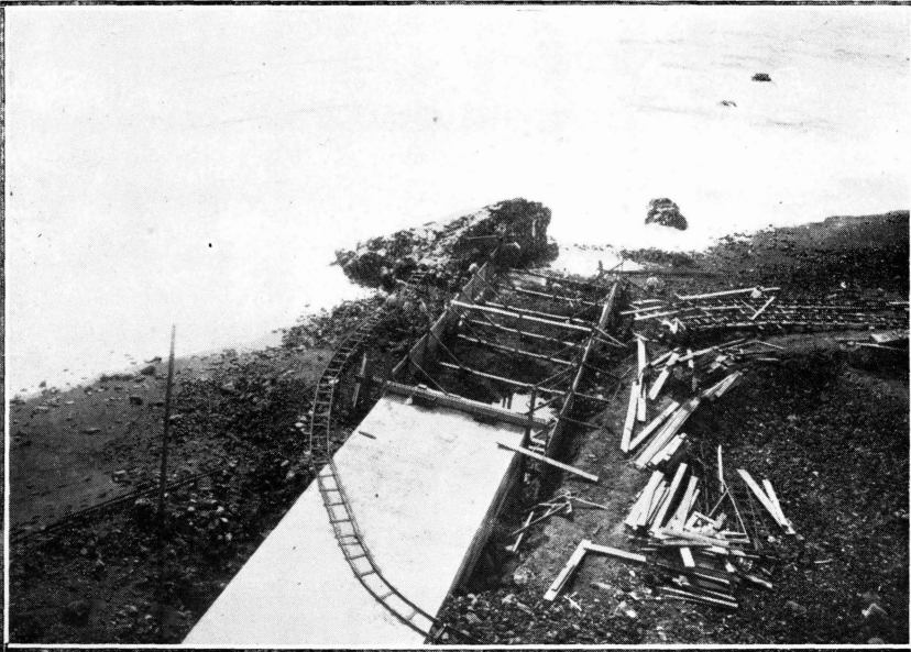
X.—Encofrado del monolito.
