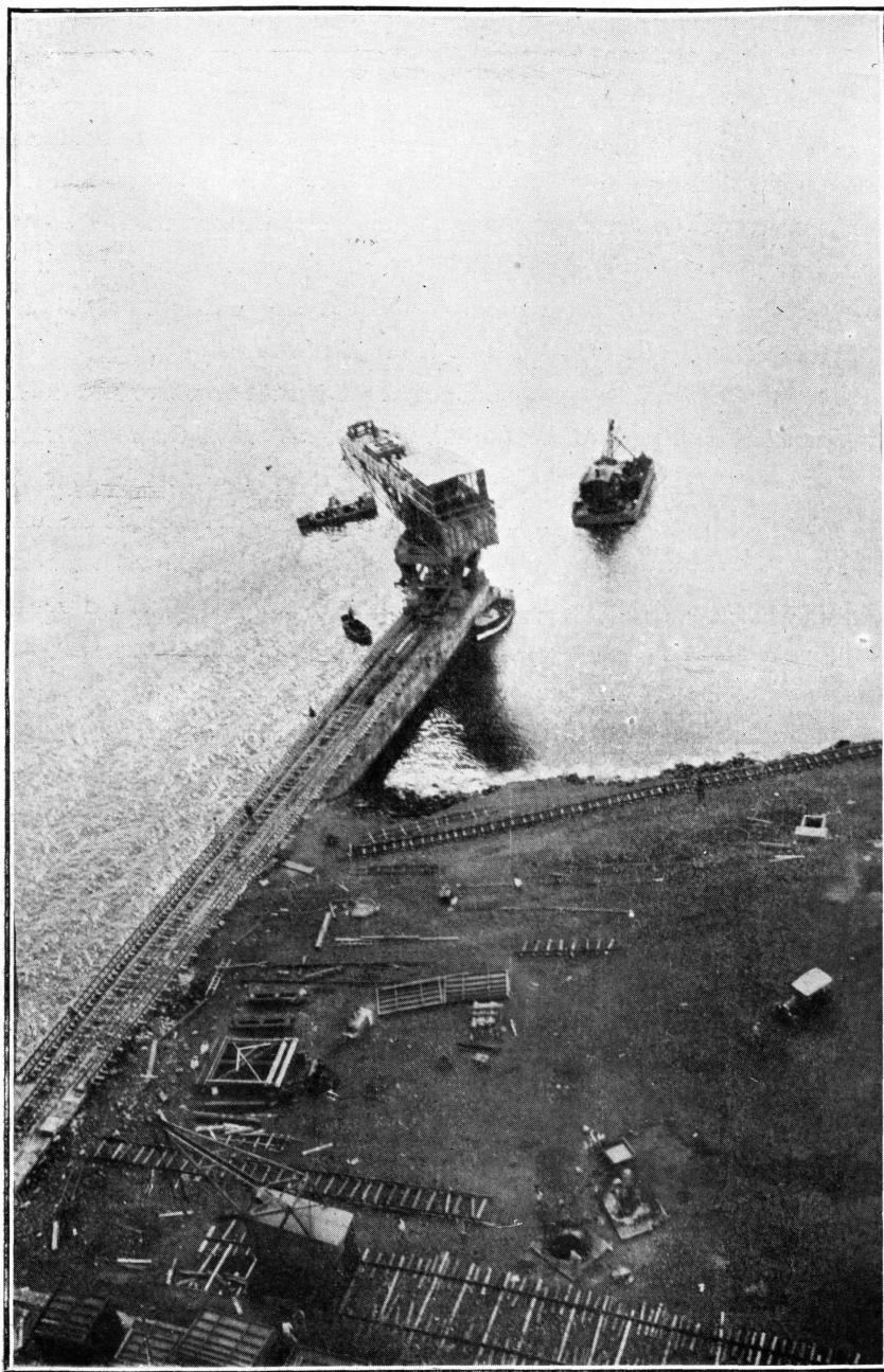
XX.—Vista del dique y Titán desde la torre de elevación de hormigón.
