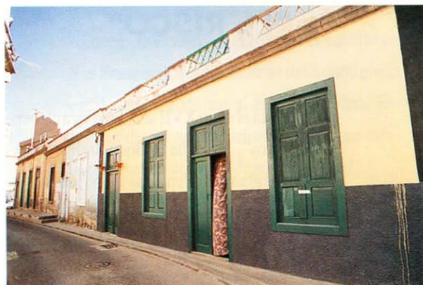
Hilera de viviendas terreras, en la vía principal y que necesitan urgente restauración.
