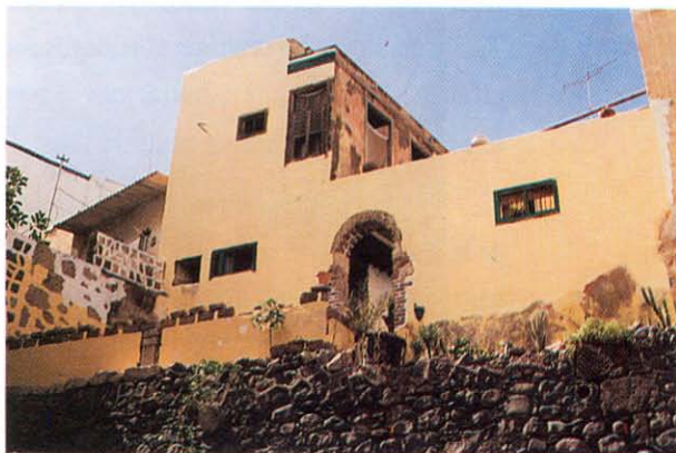
Trasera de vivienda particular en rehabilitación, situada en la calle Domingo Guerra del Río.
