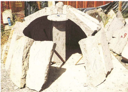
Construcción de un horno de pan abovedado.
