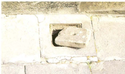
Tapas de alcantarilla y “arquillas” para el agua.
