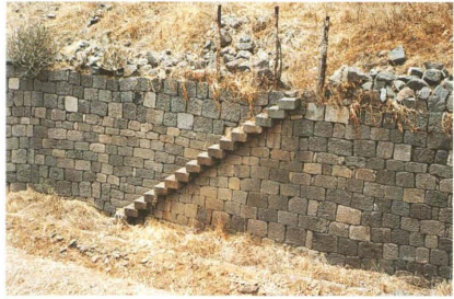
Muro y escalera de piedra.
