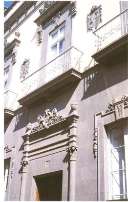
Fachada de Vegueta.
