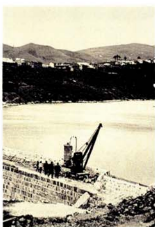
Imagen de la Presa del Pinto.
