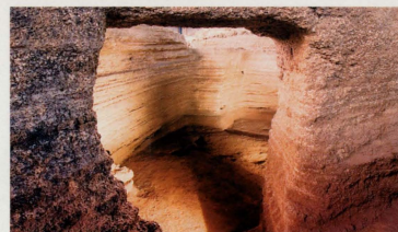
Hundimiento de las paredes de una cueva del conjunto. | ANDRÉS CRUZ
