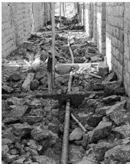
Fig. 3 2010. Fontanería en la obra del hospital de Assayta, Etiopía. (Foto del autor)
