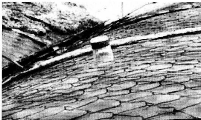
Ilustración Instalación de vasos de té en la bóveda
