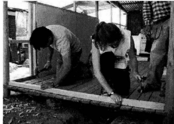
Trabajos de carpintería
