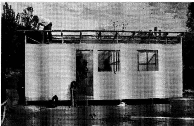
Cubierta de Zinc
