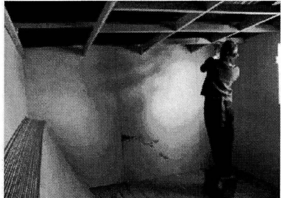
Colocación estructura falso techo
