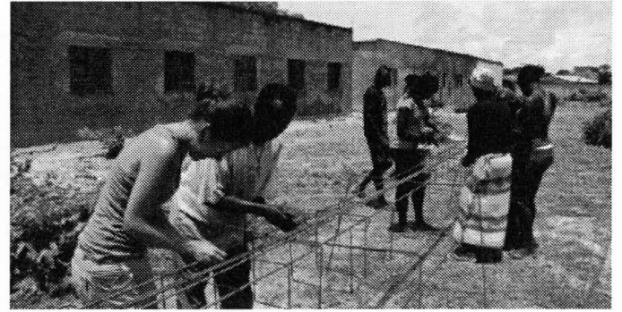
Fig. 11. Montaje de armado para cimentación
