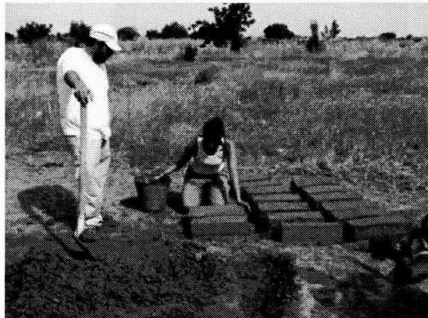
Fig. 12. Estudiantes haciendo adobe. Fase de rellenado del molde.
