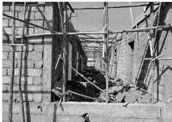
Fig. 2 2010. El andamiaje en la obra del hospital de Assayta, Etiopía. (Foto del autor)
