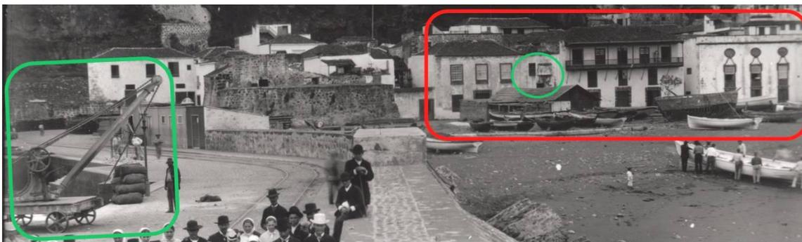
El puerto ya aparece acabado y el muro de la derecha terminado. La dársena mide sobre unos 10 metros con unos raíles que podrían servir para el movimiento de la grúa. Se ven las dos escaleras a la izquierda, junto a la grúa y ya no se divisan bloques de hormigón que protegían al castillo de las olas.
