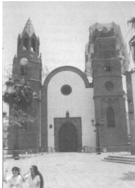
A la izquierda, imagen de las torres neogóticas de la basílica, en pésimo estado en el año 1990. A la derecha, en 1996, momento en el que se inician las obras de demolición de los pináculos de las torres para, tras años de espera, comenzar su restauración siguiendo el proyecto de Laureano Arroyo. La fotografía en color es una imagen trasera de las torres en el año 2005.
