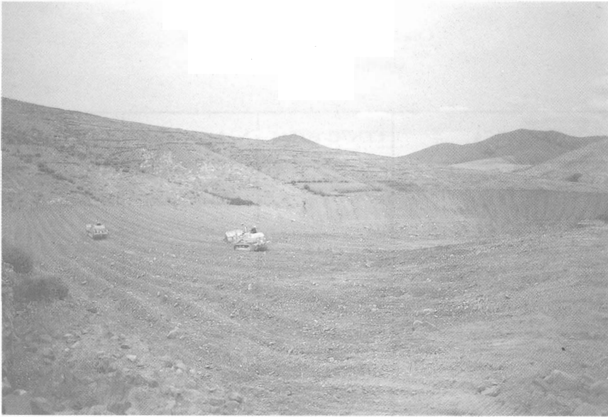
Captación de agua en zonas áridas. Presa seca del Excmo. Cabildo Insular de Fuerteventura.
