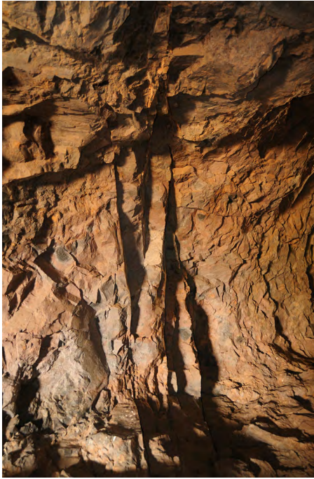
Detalle de una diaclysa existente en el terreno (interior del túnel)
