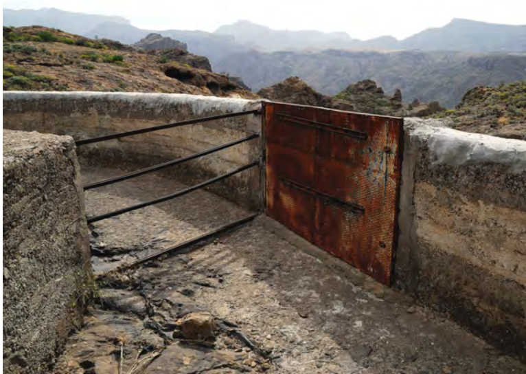
Compuerta del Canal de Majada Alta hacia la cuenca de Soria (Foto JG)
