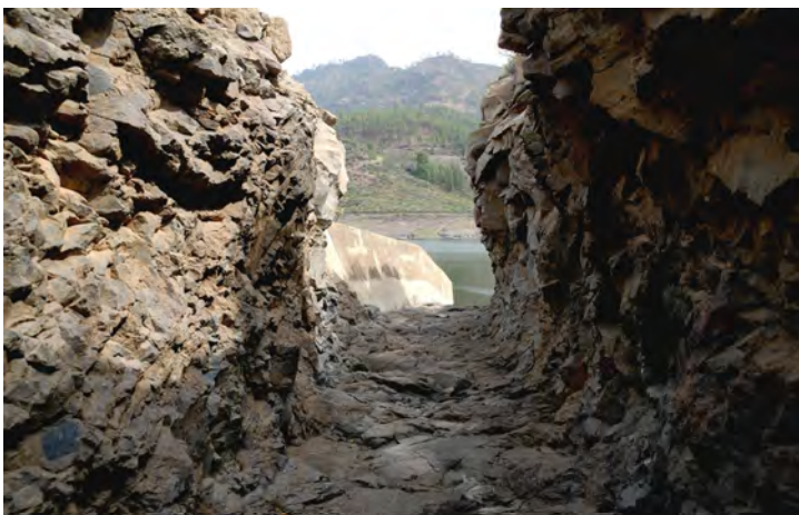
Canal de Majada Alta al embalse de la Presa de las Niñas (Foto JG)
