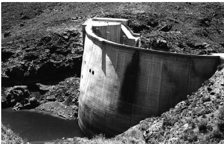
Presa de Soria
