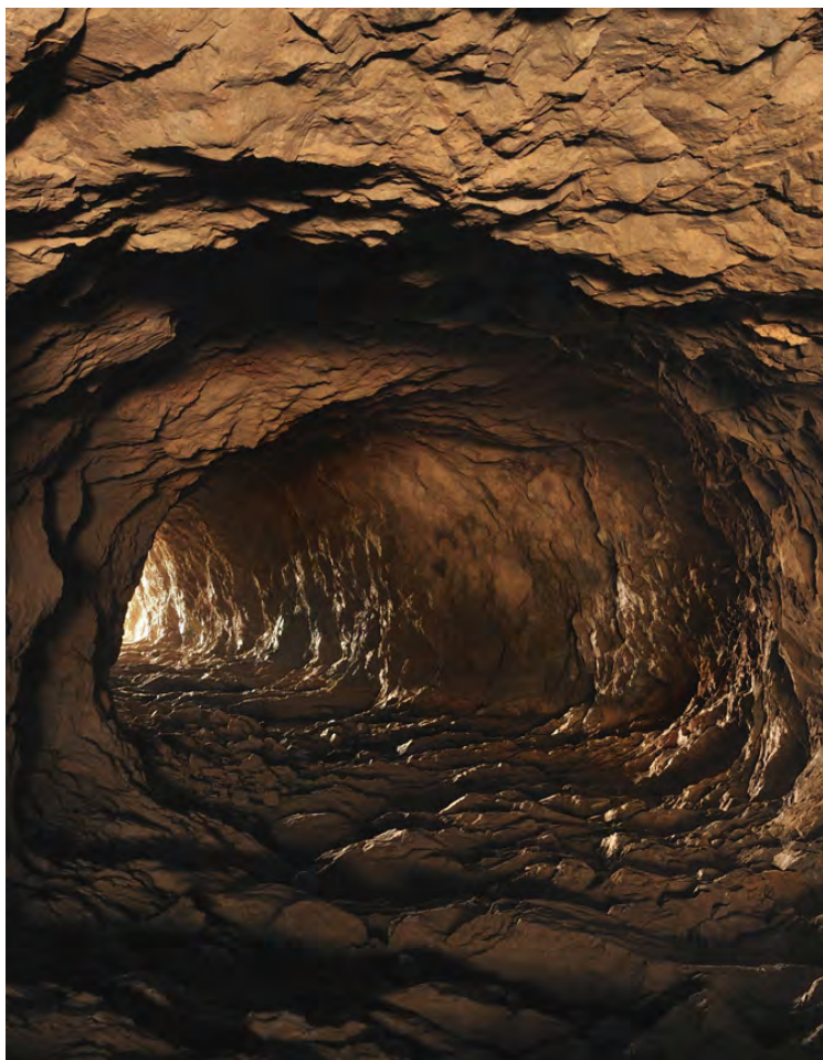
Detalle del túnel del aliviadero de la Presa de las Niñas
