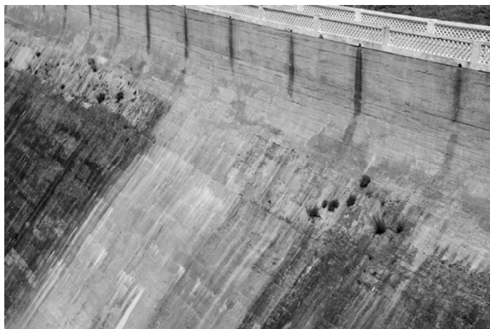
Detalle de la franja intermedia sin filtraciones ni vegetación (Foto Jaime González)
