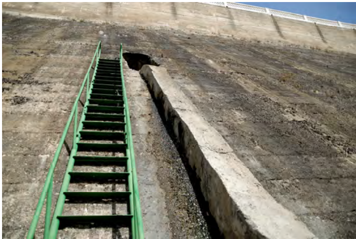
Acceso a la Galería 3 de la Presa de las Niñas (Foto JG)
