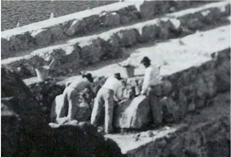
Detalle de la construcción del muro hasta los 22 metros (Fotos Comunidad de Regantes de la Presa de la Cueva de las Niñas)
