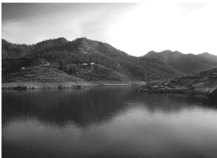
Lámina de agua, Barranco de Pilancones, Macizo de Pajonales (Foto J. Palomo)
