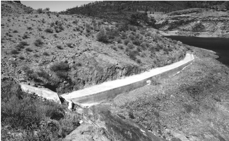
El canal del aliviadero de la presa
