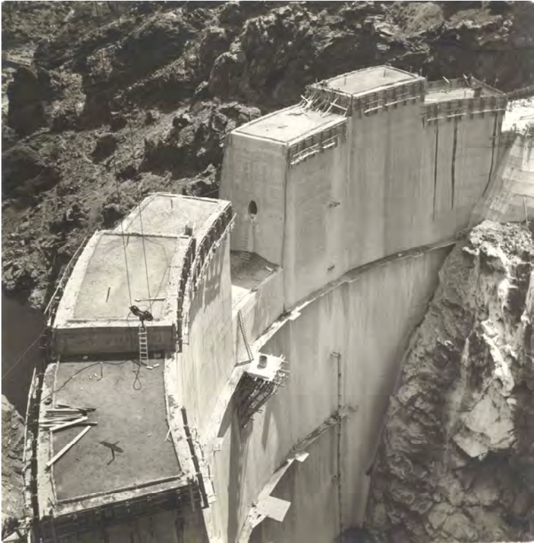
La otra gran obra de la artesanía heroica, la Presa de Soria Detalle de la construcción de la gran presa de Gran Canaria (Foto cedida por la familia Monzón)
