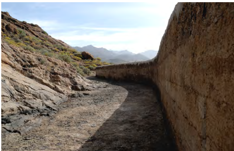
Detalle del Canal del tomadero de Majada Alta (Foto JG) (canal de roca y hormigón, terreno y obra )
