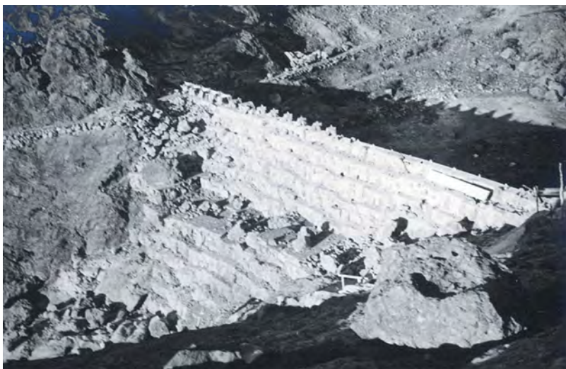
Aspecto del muro de la Presa de las Niñas ( primera etapa )
