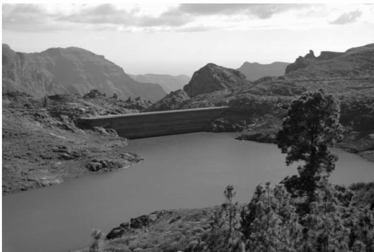
Presa de Majada Alta (Foto Jaime González)
