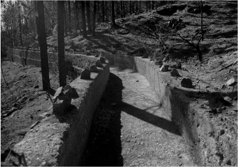
Detalle del Canal del Mulato entre los dos tomaderos Canal de 1,50 por 0,75 metros. (Fotos Jaime González)
