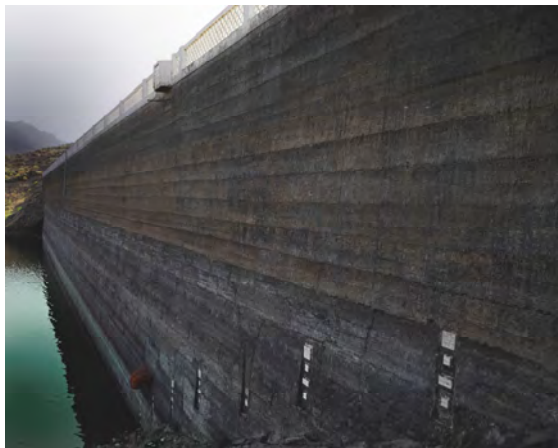
Paramento de aguas arriba (Fotos JG)
