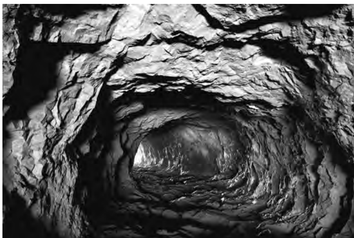
Túnel del aliviadero de la presa (Fotos J. Palomo)
