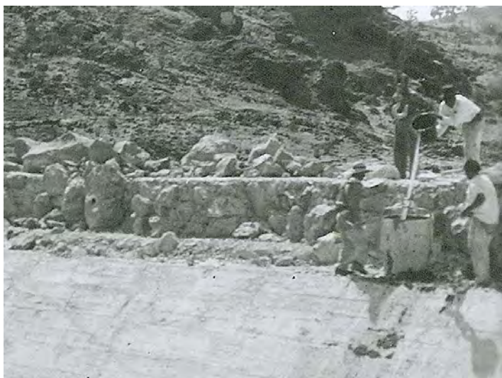
Detalle de la foto superior, trabajando en el muro.
