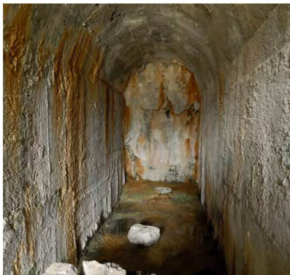
Galería 2 de la Presa de las Niñas (Foto JG)
