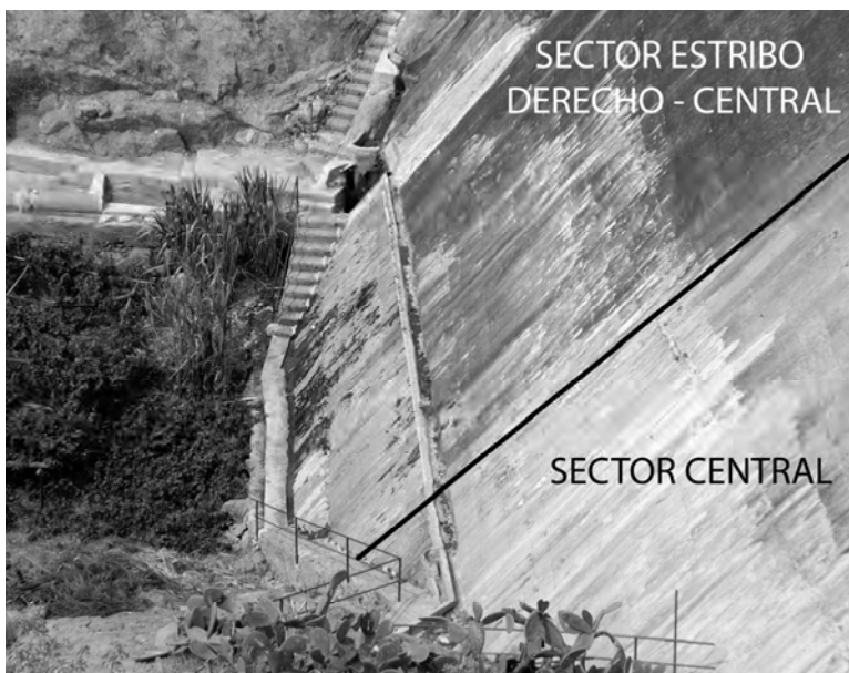
Detalle de los dos sectores del muro a pie de presa
