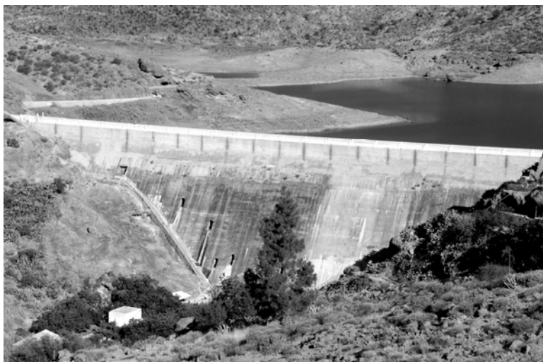
Presa de Majada Alta (Foto Jaime González)
