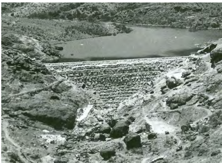
La Presa de las Niñas antes del inicio de las obras de la tercera etapa (Foto Comunidad de Regantes de la Presa de la Cueva de las Niñas)
