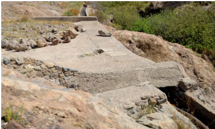
(Foto JG) El canal a su paso por la rampa de salto final de las aguas sobrantes que provienen del túnel del aliviadero de la Presa de las Niñas
