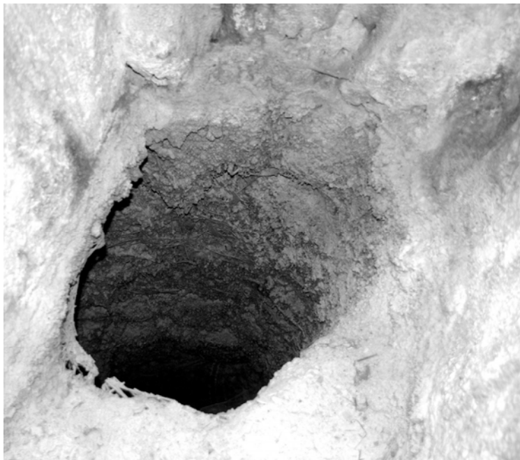
Detalle del interior del pozo hasta el agua (Foto Jaime González)
