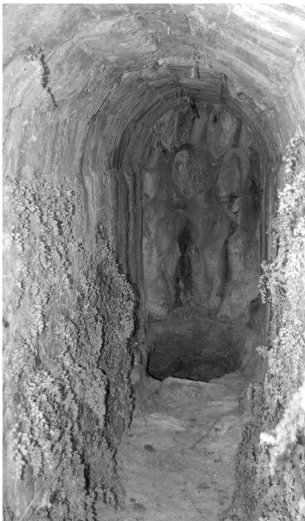
El interior de la galería 5 de la Presa de las Niñas (Foto Jaime González)
