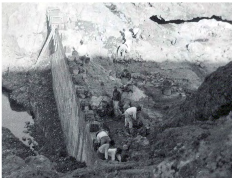
Trabajando en el muro (obras de la primera etapa) (Foto Comunidad de Regantes de la Presa de la Cueva de las Niñas)
