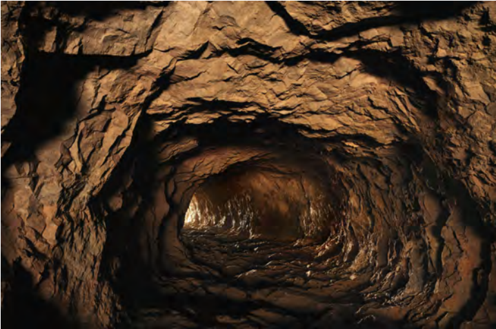
Túnel del aliviadero (Foto Juan Palomo Domínguez)
