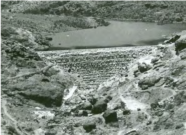
El muro antiguo de la Presa de las Niñas (Fábrica antigua)
