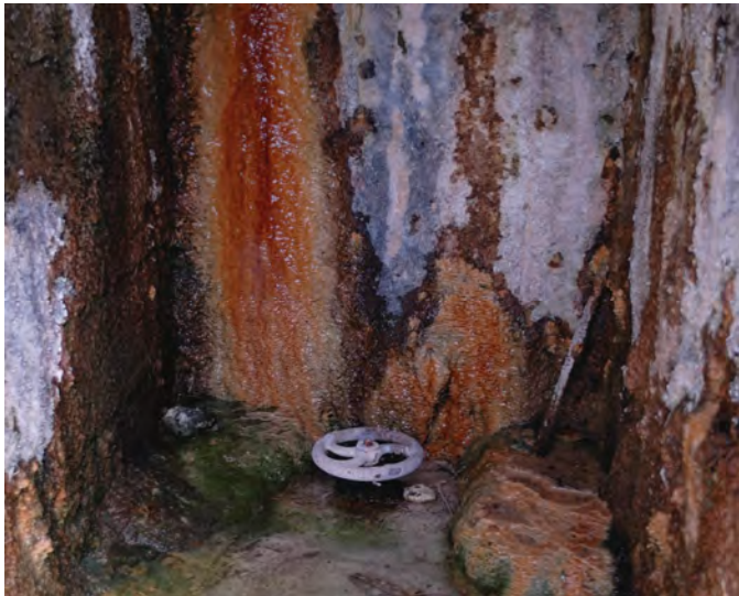
Detalle de la llave de cierre y paredes de la Galería 6
