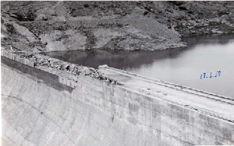
Finalizando la construcción de la Presa de las Niñas (Enero 1958) (Foto Comunidad de Regantes de la Presa de la Cueva de las Niñas)
