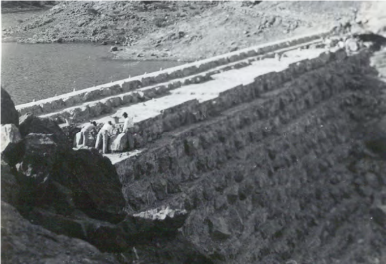
El muro de la Presa de las Niñas de la segunda etapa constructiva
