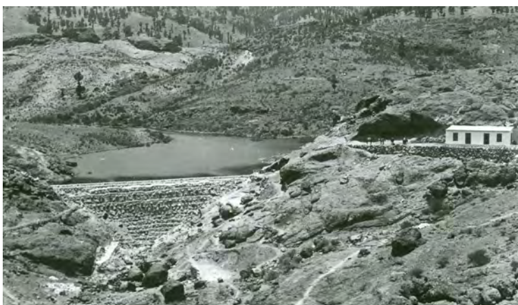
Presa de las Niñas (muro de presa con 22 metros de altura)
