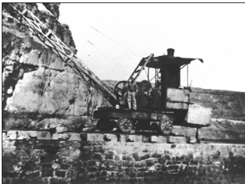
FIG. 18. Muelle de Mogán en construcción (Archivo fotográfico de Cultura. Ayuntamiento de Mogán).
