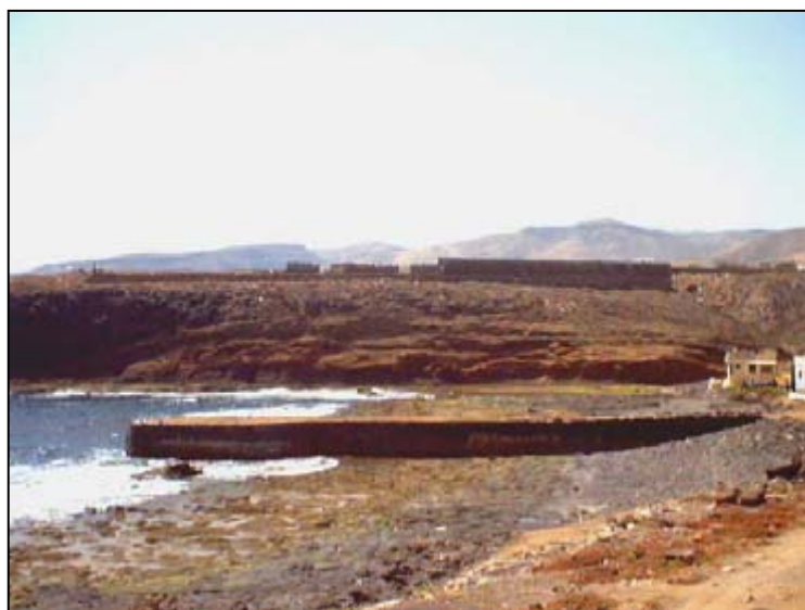
FIG. 5. Embarcadero de La Caleta de Abajo, obra de principios del siglo XX, una alternativa a Sardina en los tiempos de Sur. Fotografías de Jesús Quesada.
