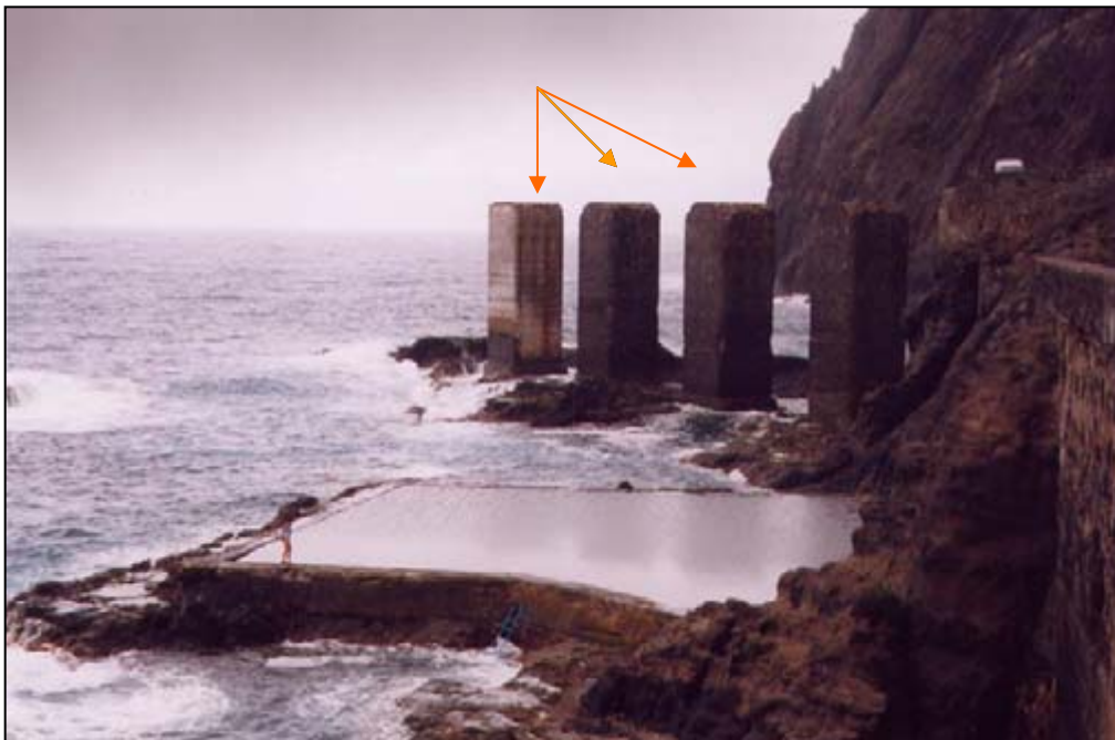
FIG. 6. Restos de un pescante en Hermigua. La Gomera, única alternativa para el embarque de productos en los mares abiertos al Norte. Imagen del autor.
