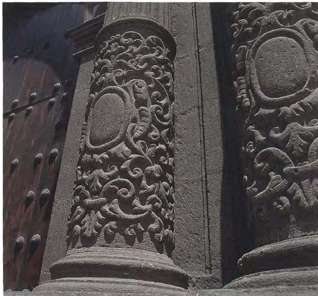
411 Portada de la iglesia de San Francisco de Asís. Detalles de las columnas pareadas
