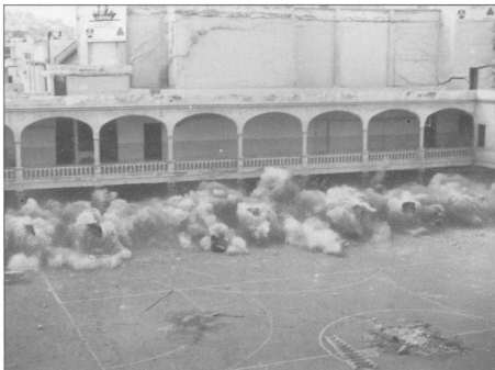
Voladura del Colegio. Agosto, 1973.
