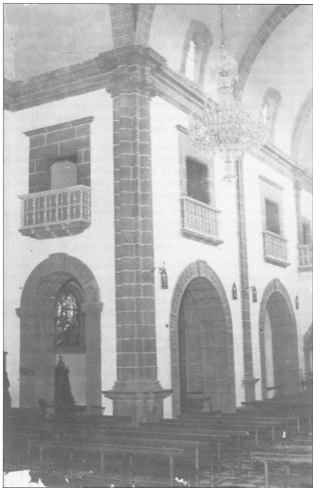
La reforma de 1944, abertura de las naves laterales.
