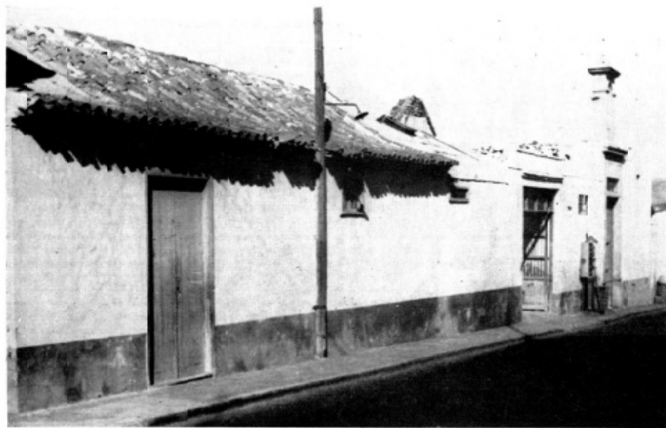
Foto 1.—Hospital de Telde
