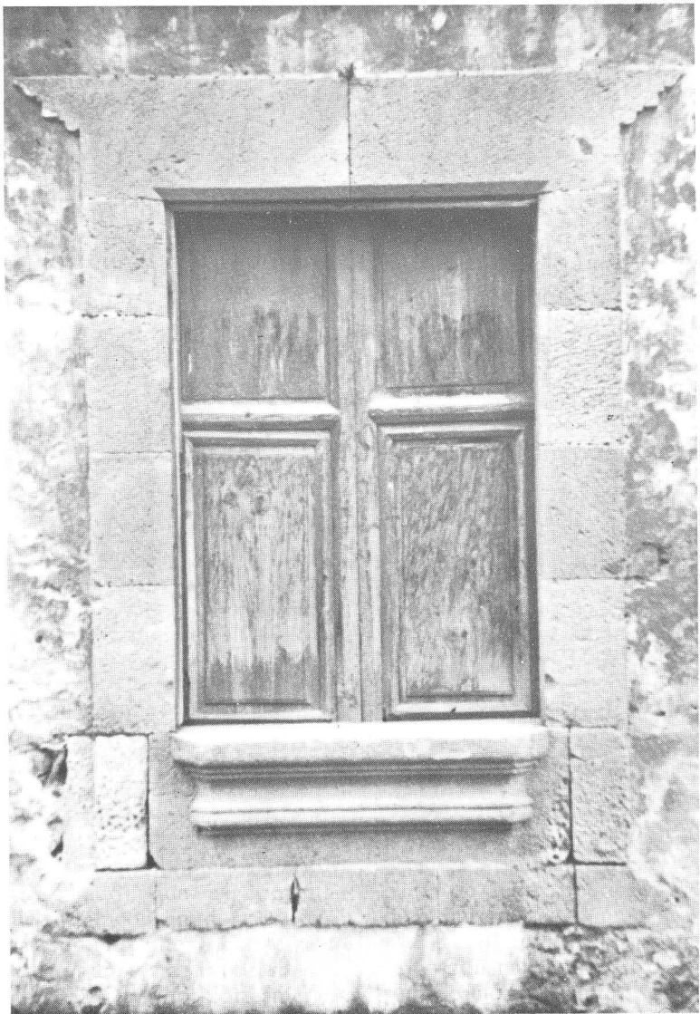
Ventana del cuerpo inferior de la fachada principal
