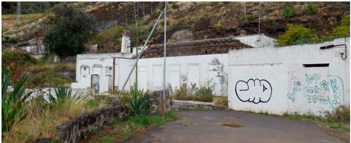
23 | Solar de la Portada Sur y ruinas de las edificaciones aledañas; en primer término, restos del muro del paso de Barreto y troneras, 2019. Archivo de la Oficina Técnica del Ayuntamiento de Santa Cruz de La Palma
