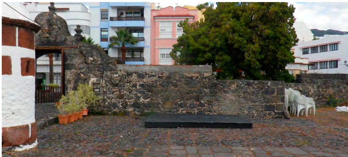
31 | Solar de las caballerizas del castillo de Santa Catalina, 2019. Archivo de la Oficina Técnica del Ayuntamiento de Santa Cruz de La Palma
