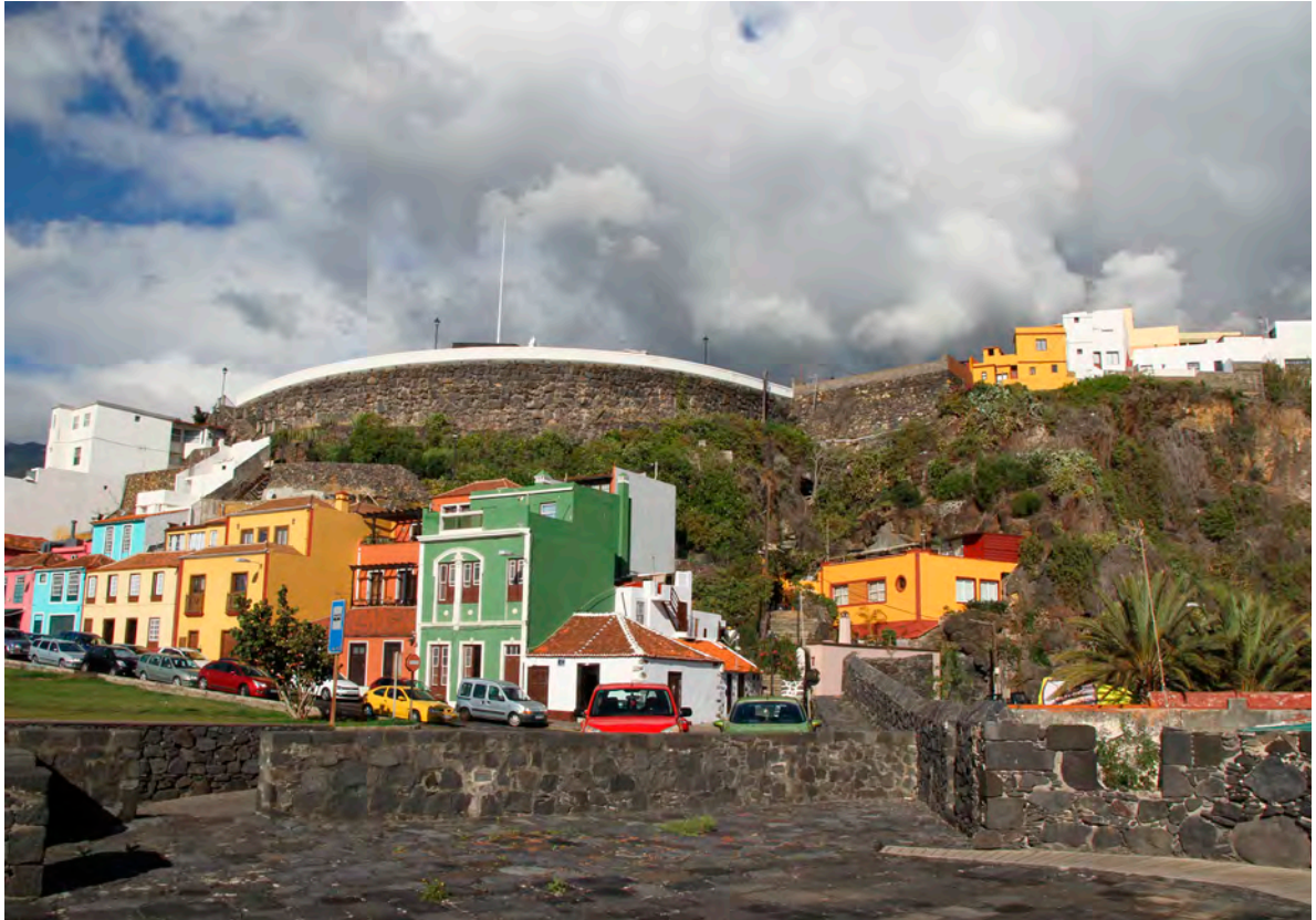
43 | Plaza de San Fernando, lomo de La Encarnación y muralla de la Portada Norte desde el castillo de Santa Cruz del barrio del Cabo; a la derecha, en tableros de madera, acceso a la batería subterránea de la fortificación, 2019. Archivo de la Oficina Técnica del Ayuntamiento de Santa Cruz de La Palma
