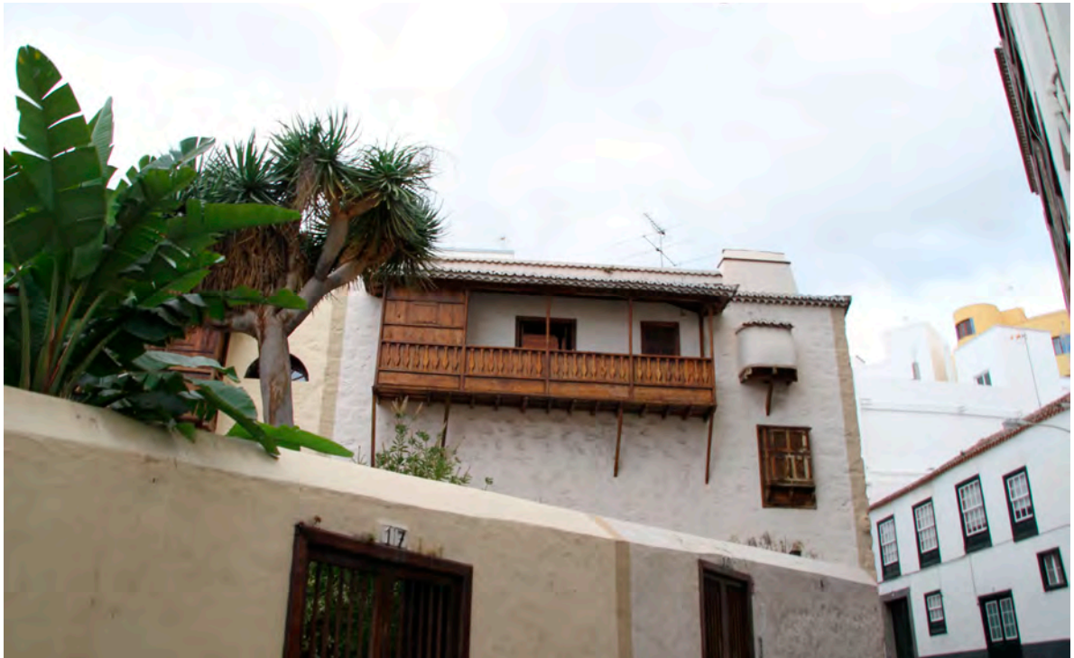
12 | Trasera de la casa Díaz (calle Pedro Poggio, número 12) por la calle Cabrera Pinto; el jardín o huerto presenta cerramiento con tapia a dos aguas y puerta de acceso a la calle y en el inmueble se distinguen: en la tercera planta, balcón cubierto con retrete a la izquierda y horno, y, en la segunda, ventana ajimez, 2019. Archivo de la Oficina Técnica del Ayuntamiento de Santa Cruz de La Palma
