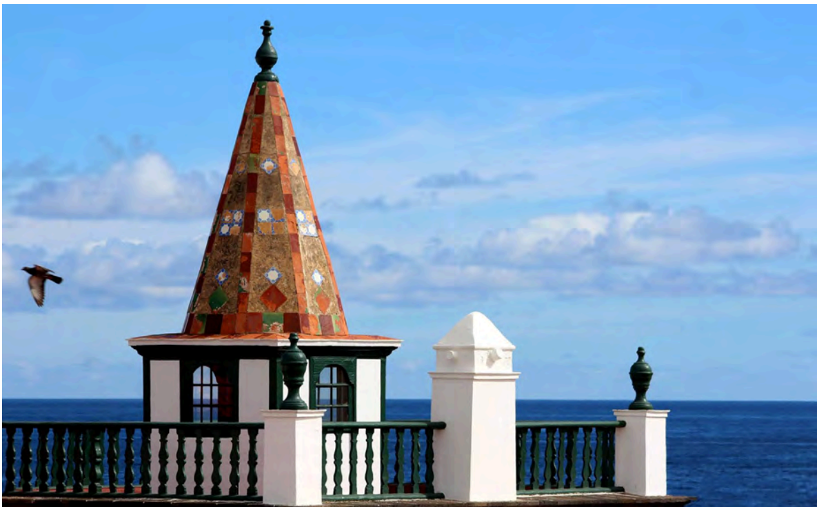
15 | Mirador-lucernario de la casa Massieu Tello de Eslava (plaza de España, número 4), de traza piramidal y forrado con piezas de cerámica andaluza, construido hacia 1789; elemento recurrente en una ciudad portuaria como Santa Cruz de La Palma destinado al control del tráfico atlántico, 2019. Archivo de la Oficina Técnica del Ayuntamiento de Santa Cruz de La Palma
