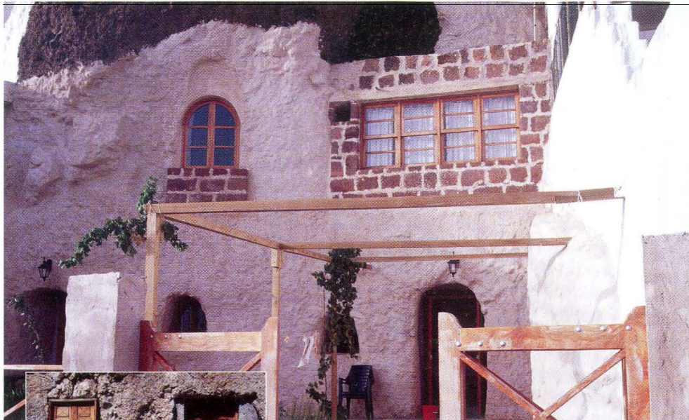
Vivienda cueva rehabilitada. Artenara.
