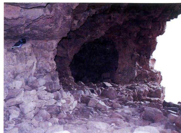
Túnel de acceso a la Fortaleza Grande de Tirajana.
