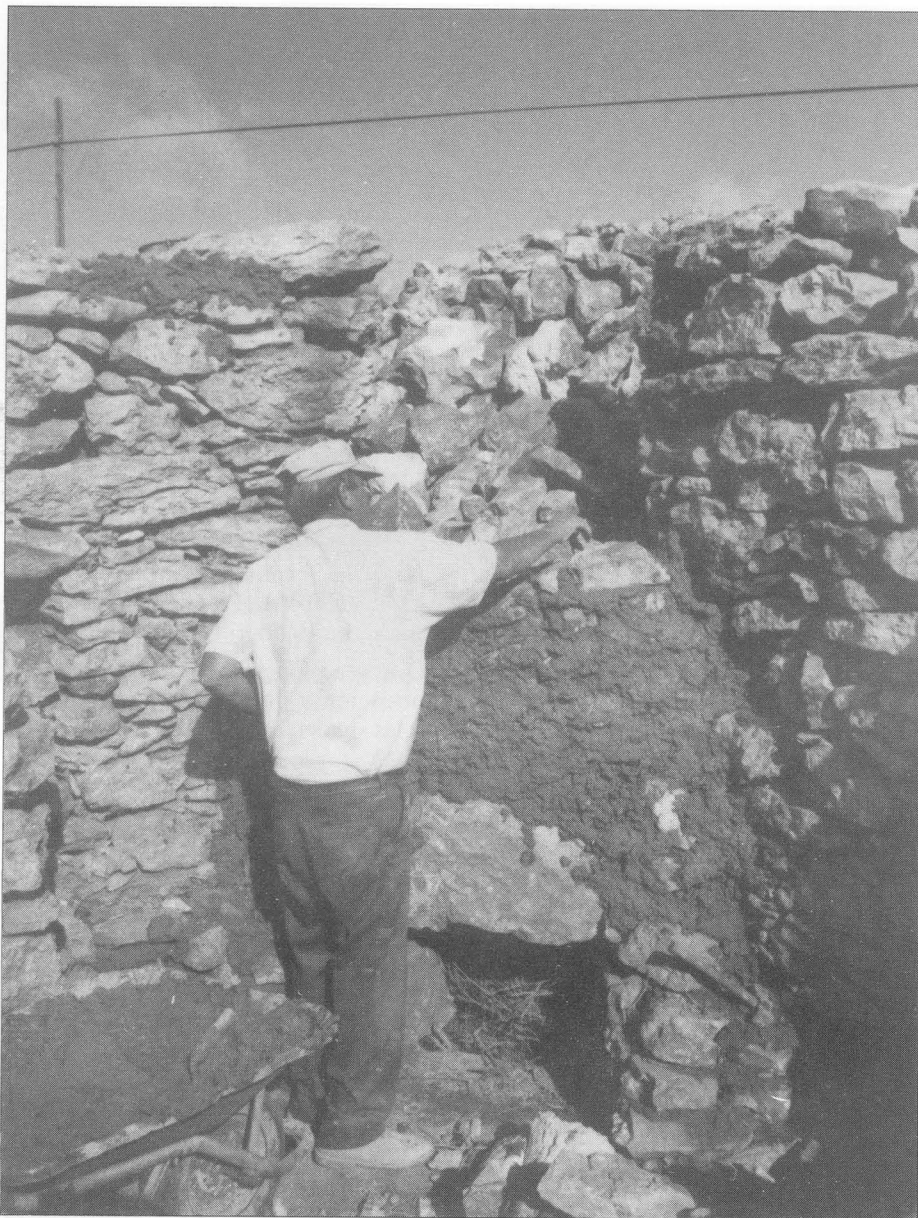
Preparación de un horno de leña (doméstico), construcción de "pecho"
