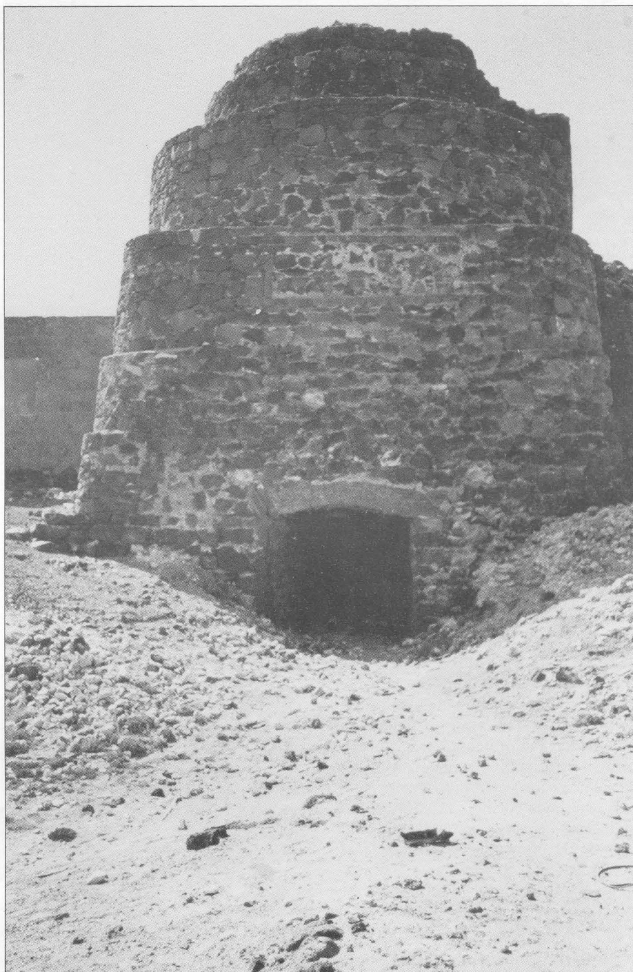
Horno de cal de Las Hormigas en Los Pozos, Puerto del Rosario
