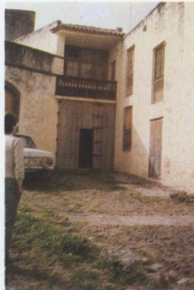
Entrada al molino de Enmedio de los Herederos de Bernardino Santana —Arucas— Lomo San Pedro-La Goleta.
