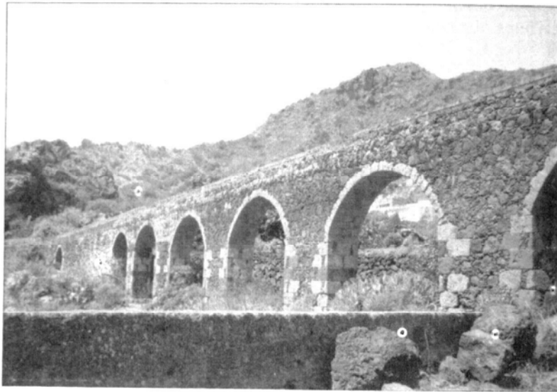
Heredad de Las Palmas y Dragonal Acueducto que conducía el agua al molino del Maípez (Molino de "Pepito Talega").
