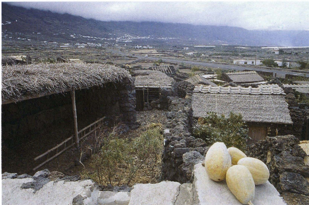
Cubierta vegetal de "colmo" (El Hierro)
