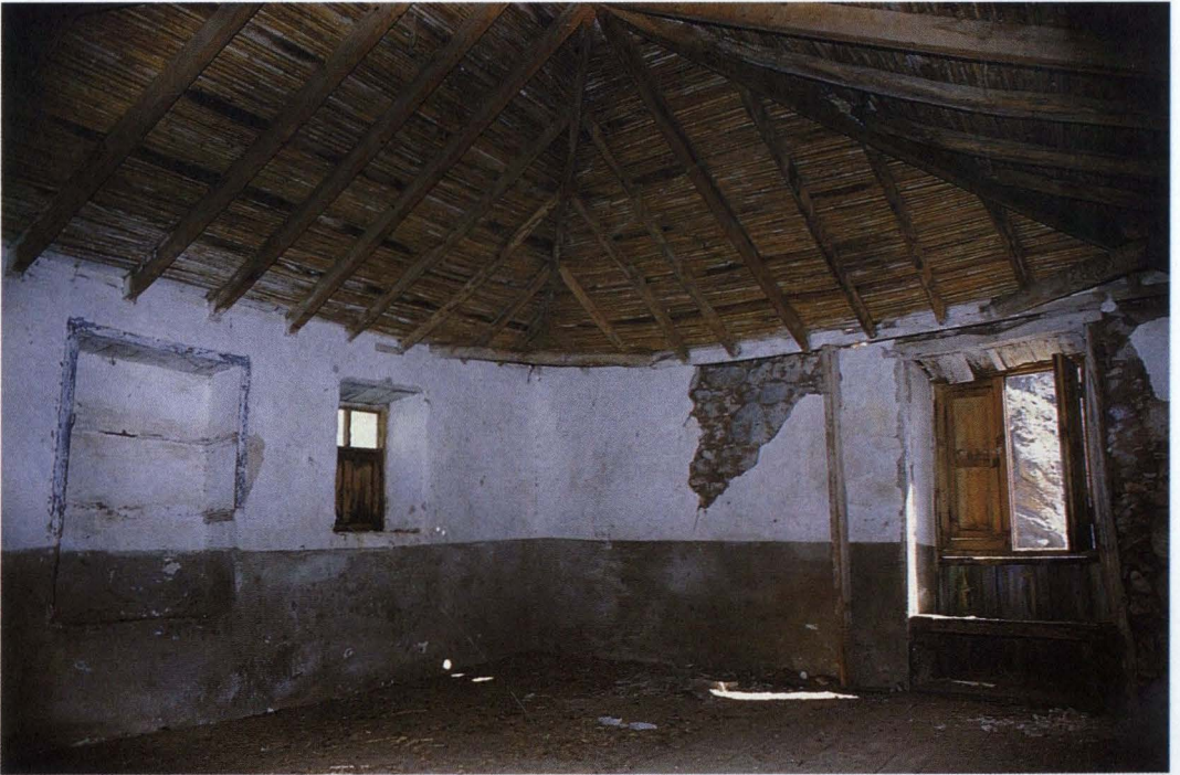
Soporte de cubierta (cañizo)
