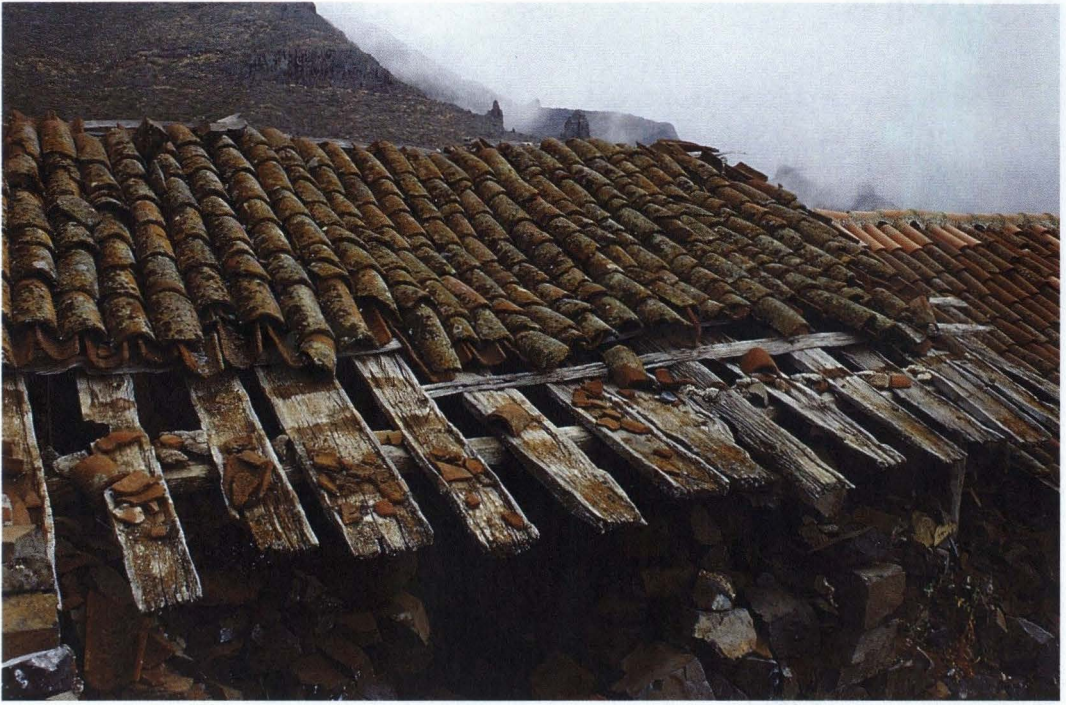
Impermeabilización parcial con canales-soporte de tea
