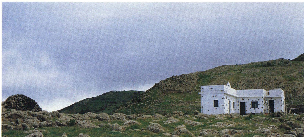
Tratamiento exterior de edificación con fácil solución
