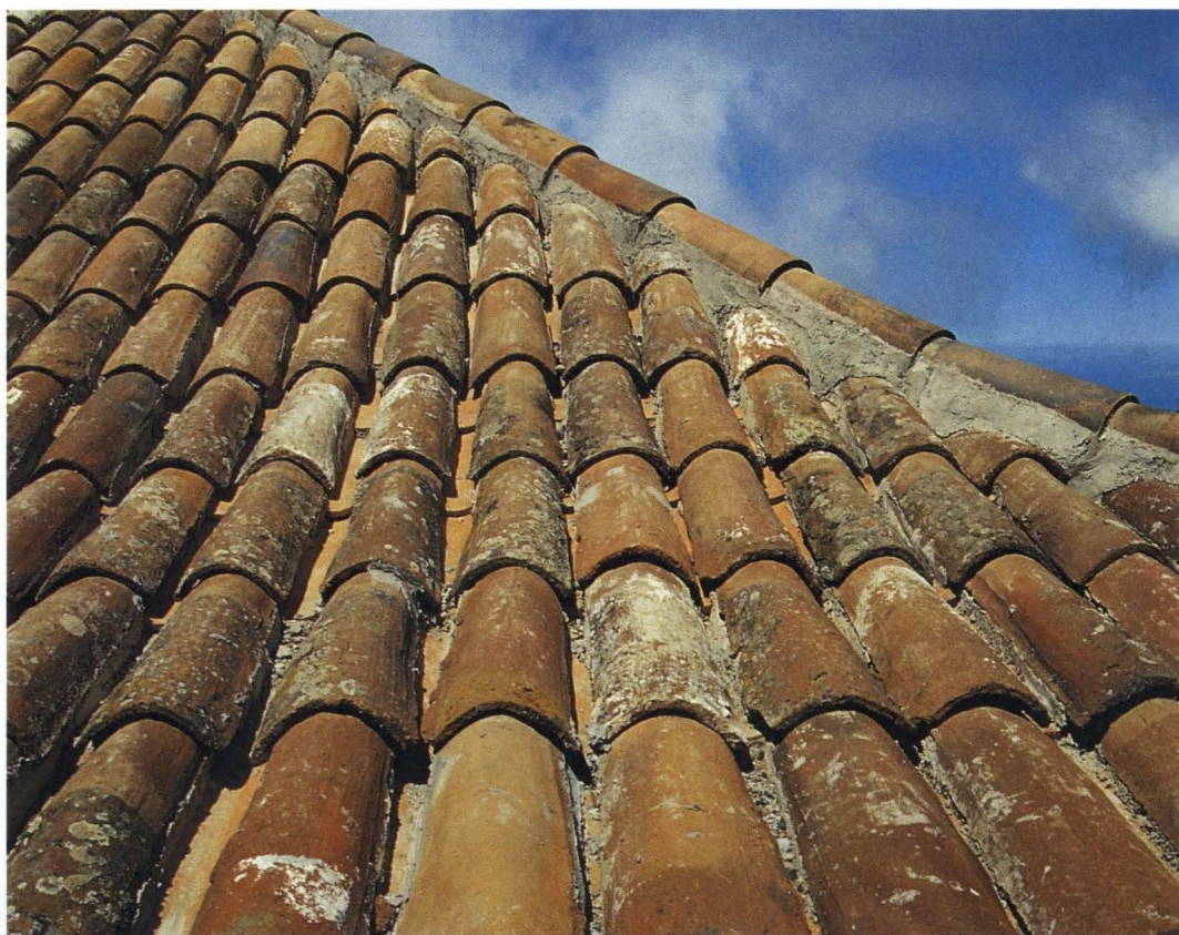
Detalle de cubierta (canales de teja impermeable)
