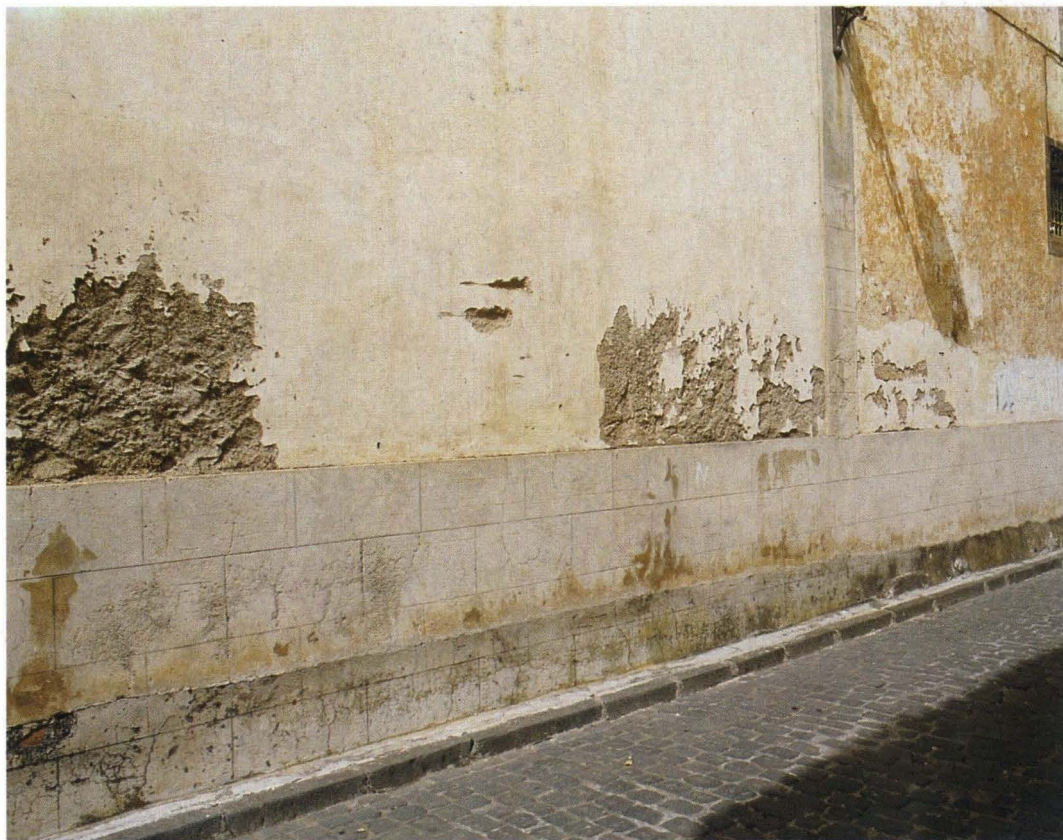
Impermeabilización exterior del zócalo (potenciación del fenómeno de capilaridad)
