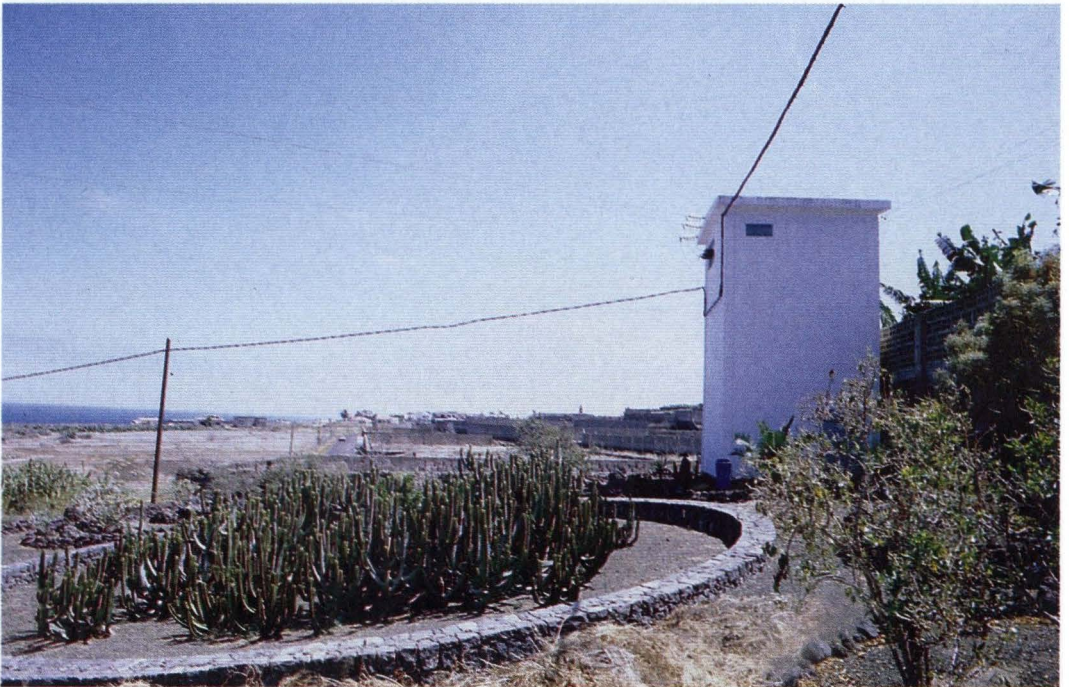
Estación transformadora y viejo cardón emblemático del municipio de Buenavista del Norte
