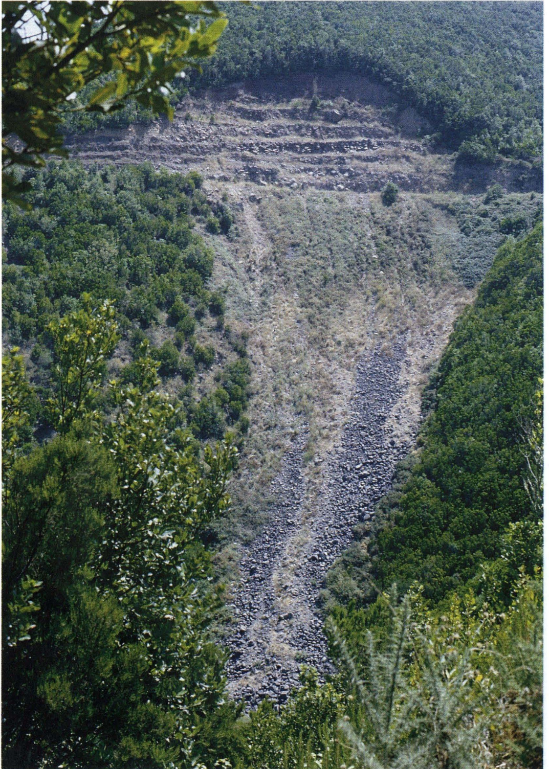
Talud inestable (Monte del Agua)
