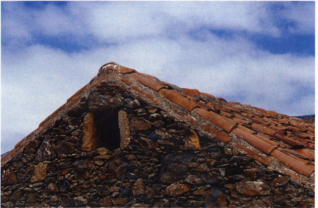
Hueco de ventilación
