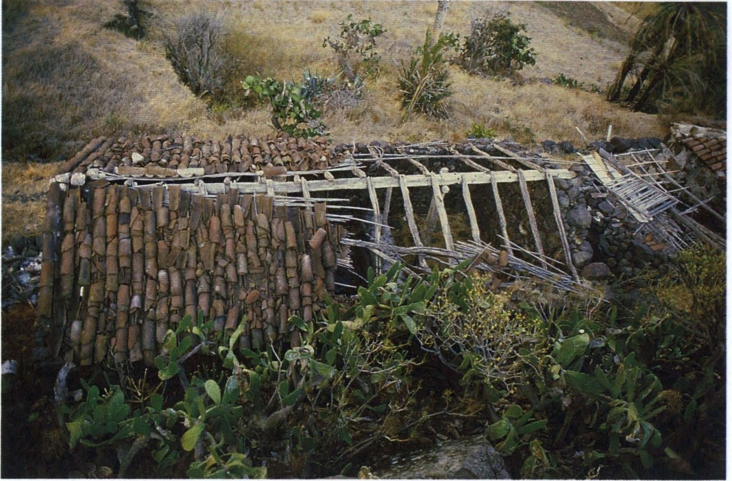
Detalle de cubierta
