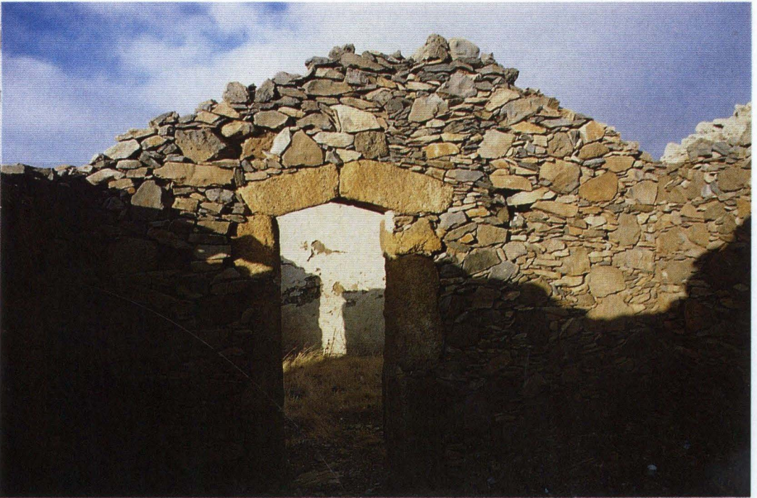
Arco de descarga
