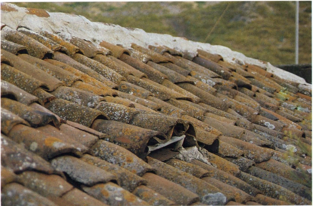
Huecos de ventilación
