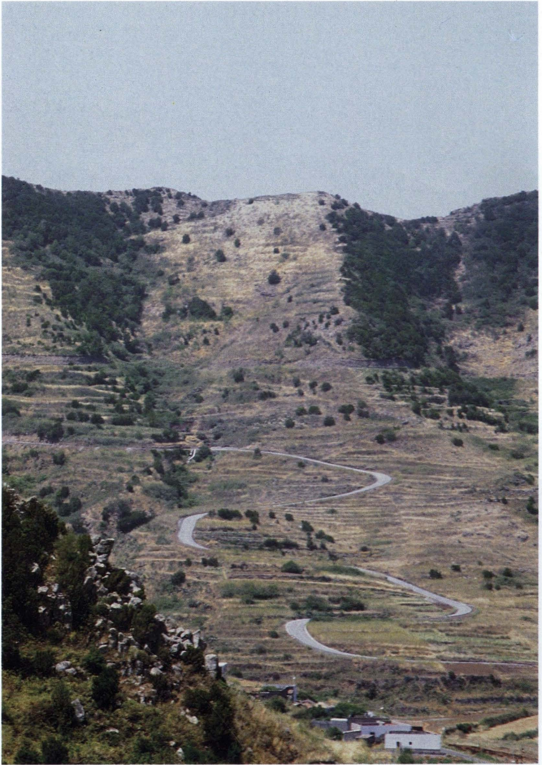
Trazados y materiales inadecuados
