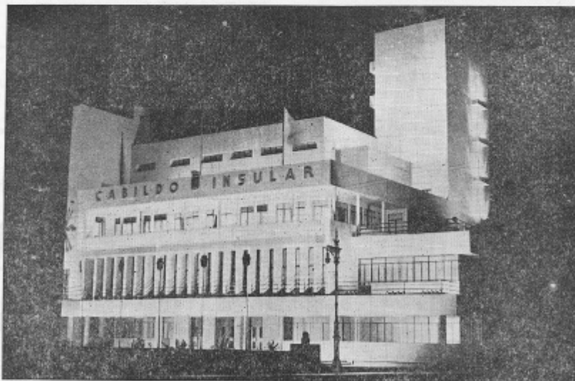
Edificio del Excmo. Cabildo Insular de Gran Canaria.
