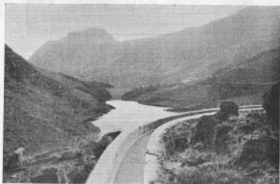
Canal de la Presa de Ayagaures.
