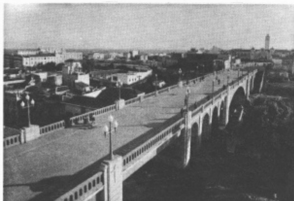
Puente «GENERAL SERRADOR» en Santa Cruz de Tenerife.
