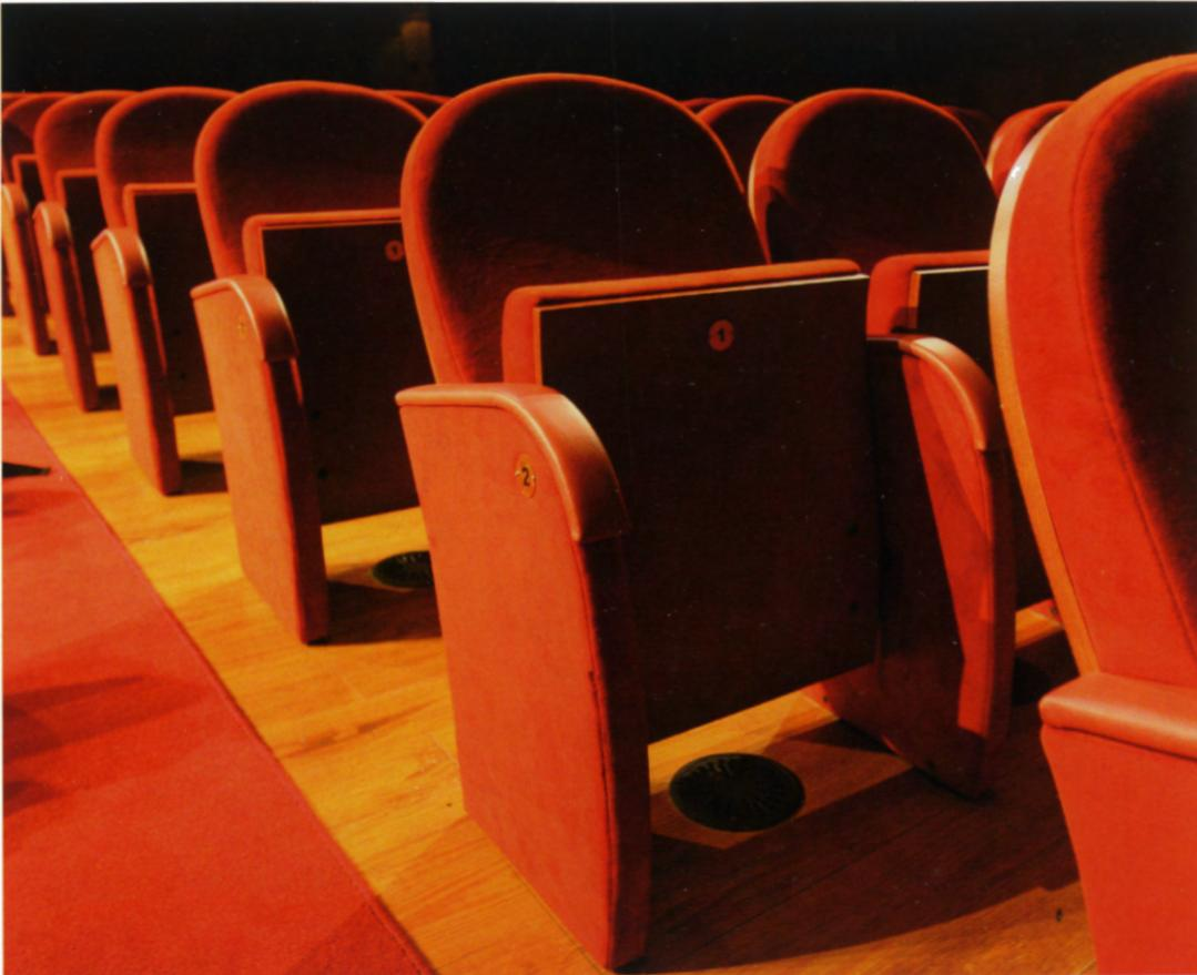
Detalle de las butacas de la platea. Se aprecia la salida del aire acondicionado por una tobera redonda ubicada bajo cada butaca.
