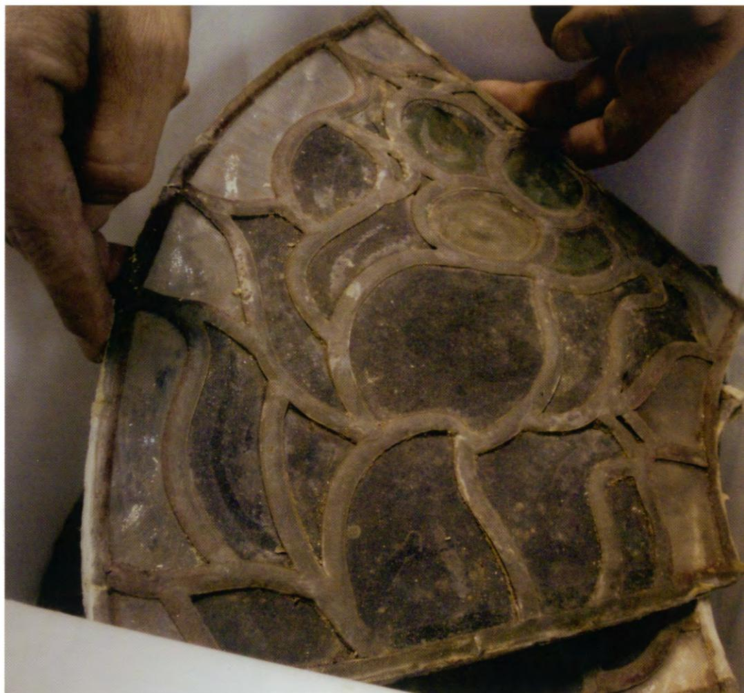
La linterna central del falso techo es una pieza muy importante del teatro. Hay que pensar que dispone de ventanucos que se abren para que la sala pueda "respirar". La garantía de la seguridad y estabilidad de sus elementos componentes ha de ser total para evitar caídas no deseadas. Por el estado en el que se encontraba, fue necesario retirarla en su integridad.
