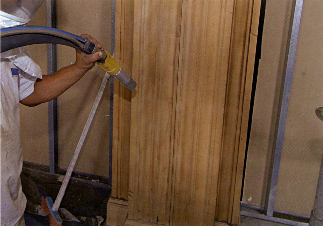
La limpieza principal que se le efectuó a la madera, independientemente de la eliminación de polillas y otros insectos, se efectuó con pistola de gunitado que lanzaban polvo de silicato de aluminio, con extraordinario resultado de limpieza y abrillantado.
