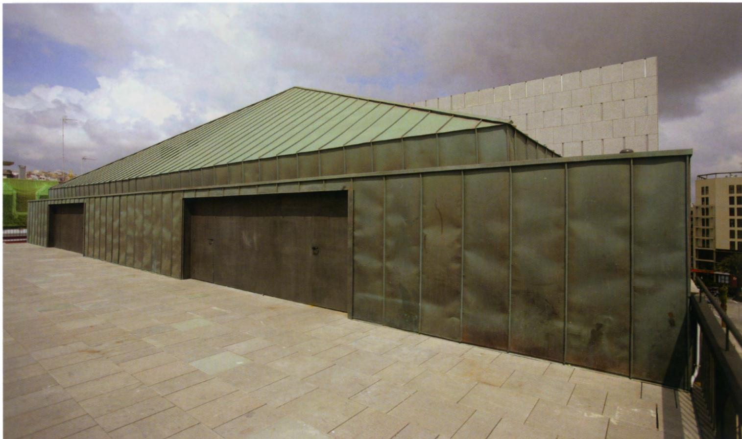
Terraza visitable y cubrición actual de la sala principal. Para lograr el máximo aislamiento acústico de la sala se recurrió a materiales "especializados", protegidos por una envolvente de lámina metálica de cobre.
