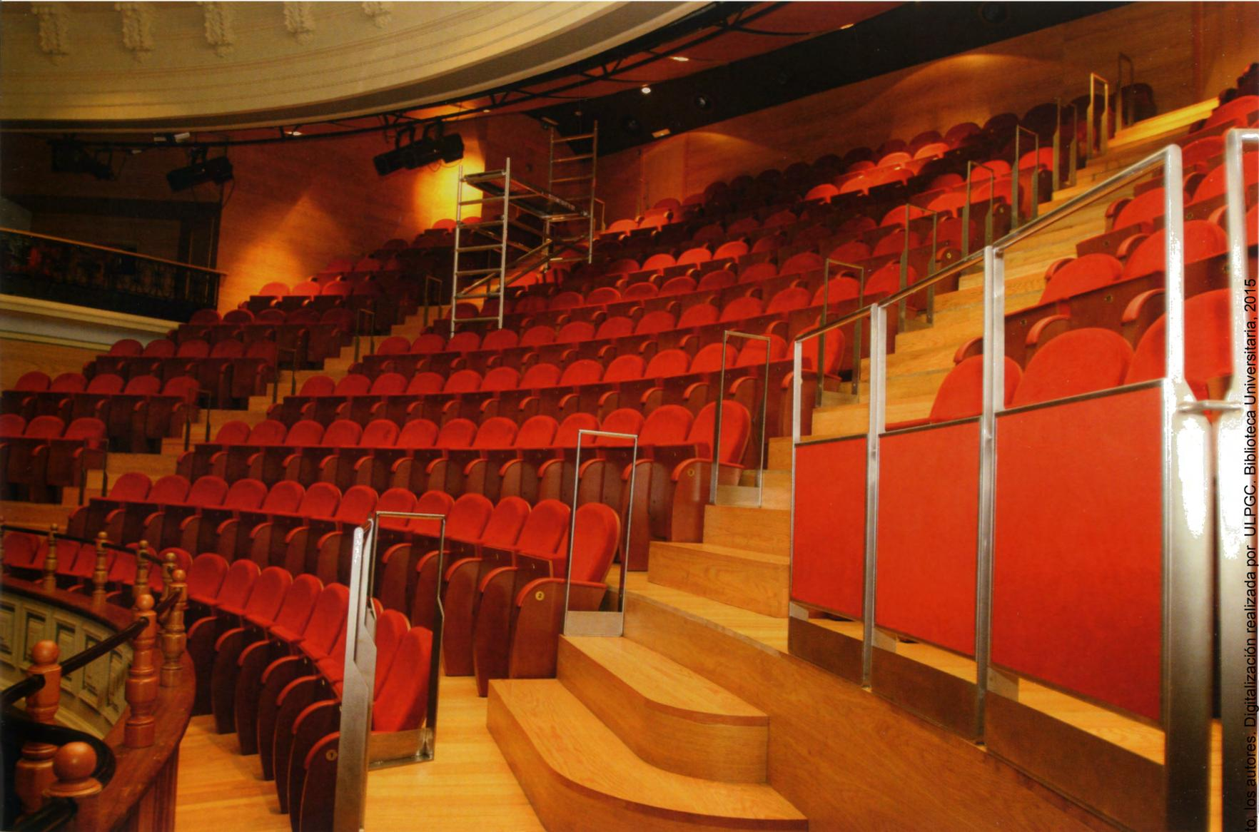
Para lograr una grada única como resultado de la unión de las antiguas gradas de paraíso y general (gallinero) y acoplar las cotas o alturas de accesos a escaleras y terraza, fue necesario dar una pendiente de gran inclinación a la grada resultante.
