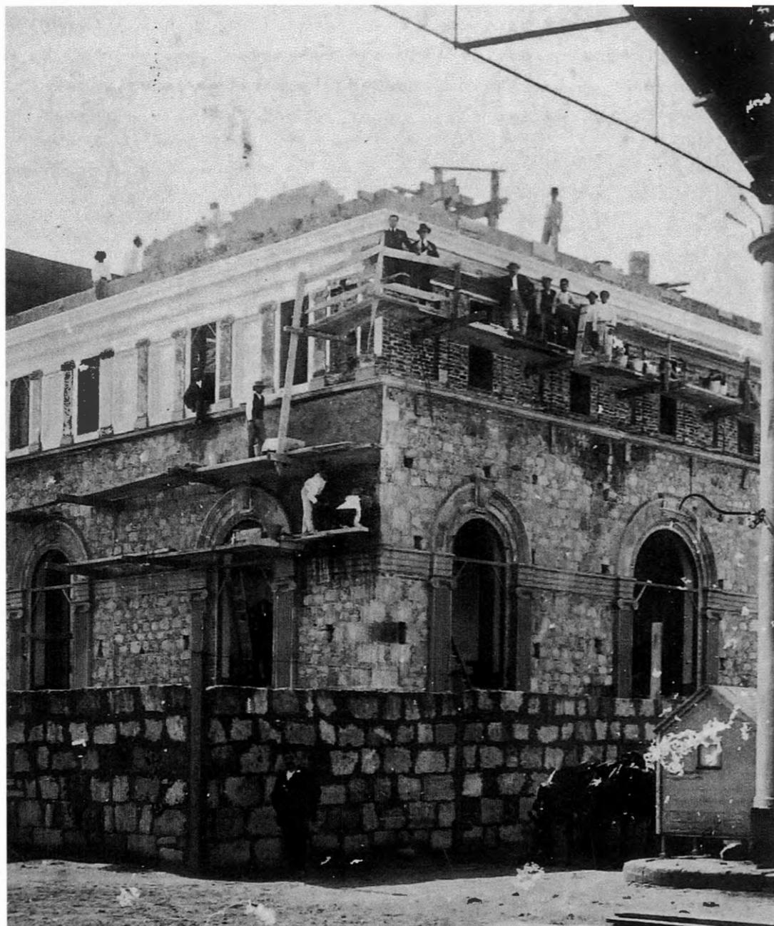
Imagen de la obra de la ampliación del teatro planteada por Fernando Navarro después del incendio. En el ángulo superior derecho de esta fotografía se pueden observar unos elementos de estructura metálica apoyando sobre pilar metálico de sección redonda que corresponden al tinglado de secadero de pescado.
