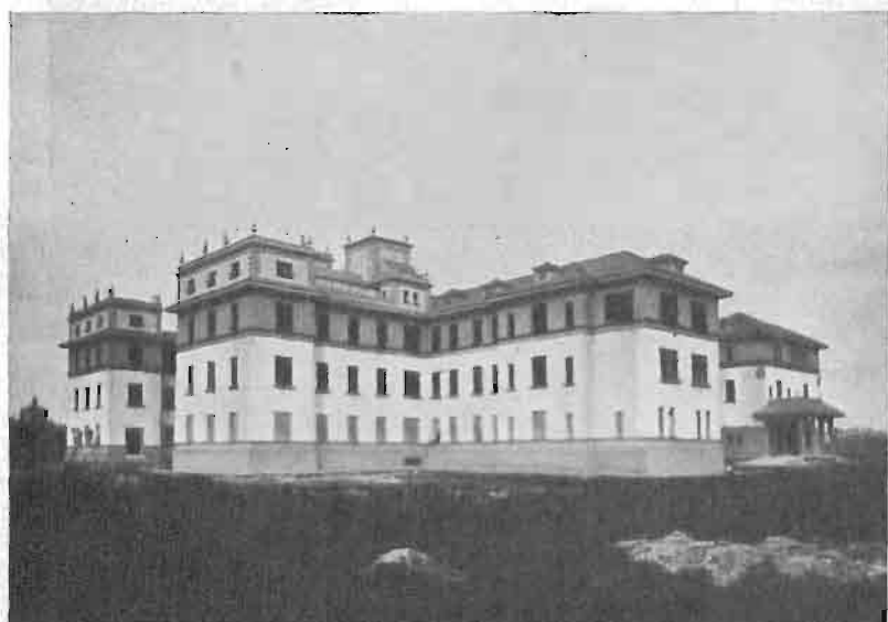
Nuevo Hospital Español Vista del Pabellón de Consultorios Externos, tomado desde atrás
