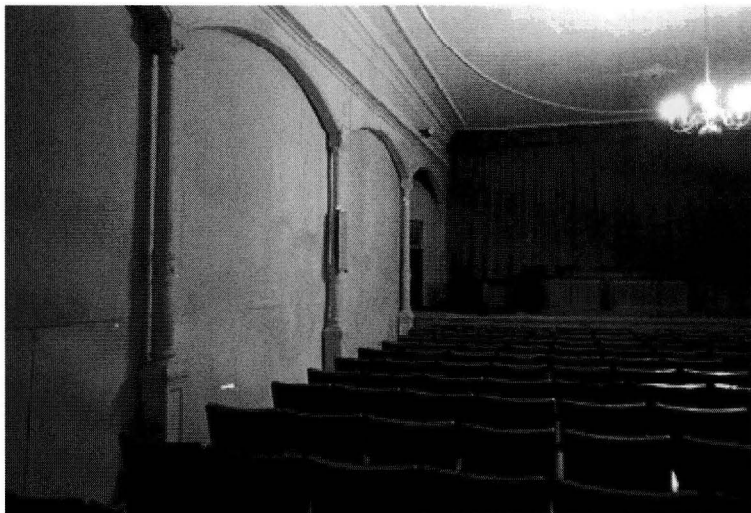
Figura 82. Aspecto que ofrecía el Salón de actos tras su reforma, en los años 70. Fuente: Archivo Municipal y Fundación Canaria Néstor Álamo
