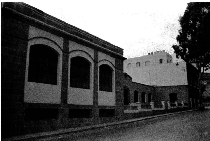
Figura 14. Instituto Laboral de Guía, fachada oeste. Fuente: Archivo Municipal y Fundación Canaria Néstor Álamo
