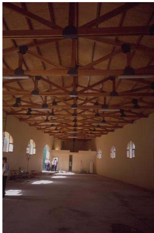
Il. 2.- Vista interior de la antigua sala de embotellado, ya restaurada.
