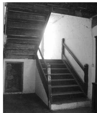
Vista de la escalera principal.
