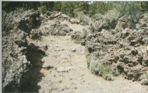
Acondicionamiento de parte del suelo del Camino en el tramo entre el Dornajito y el Portillo de la Villa.
