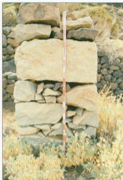
Ejemplo de técnica constructiva en un muro histórico. Cañada de La Grieta.
