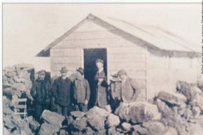
Construcción de la cabaña que sirvió para la base de las observaciones astronómicas en Guajara. (J. MASCART: Impressions et observations...op. cit., pp. 49).
