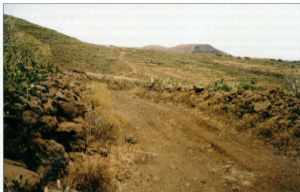
Trazado actual del camino viejo de Candelaria, construido por el Cabildo en 1531, en el tramo correspondiente a los Baldíos de Geneto.
