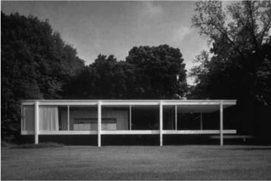
Casa Farnsworth, panorámica exterior
