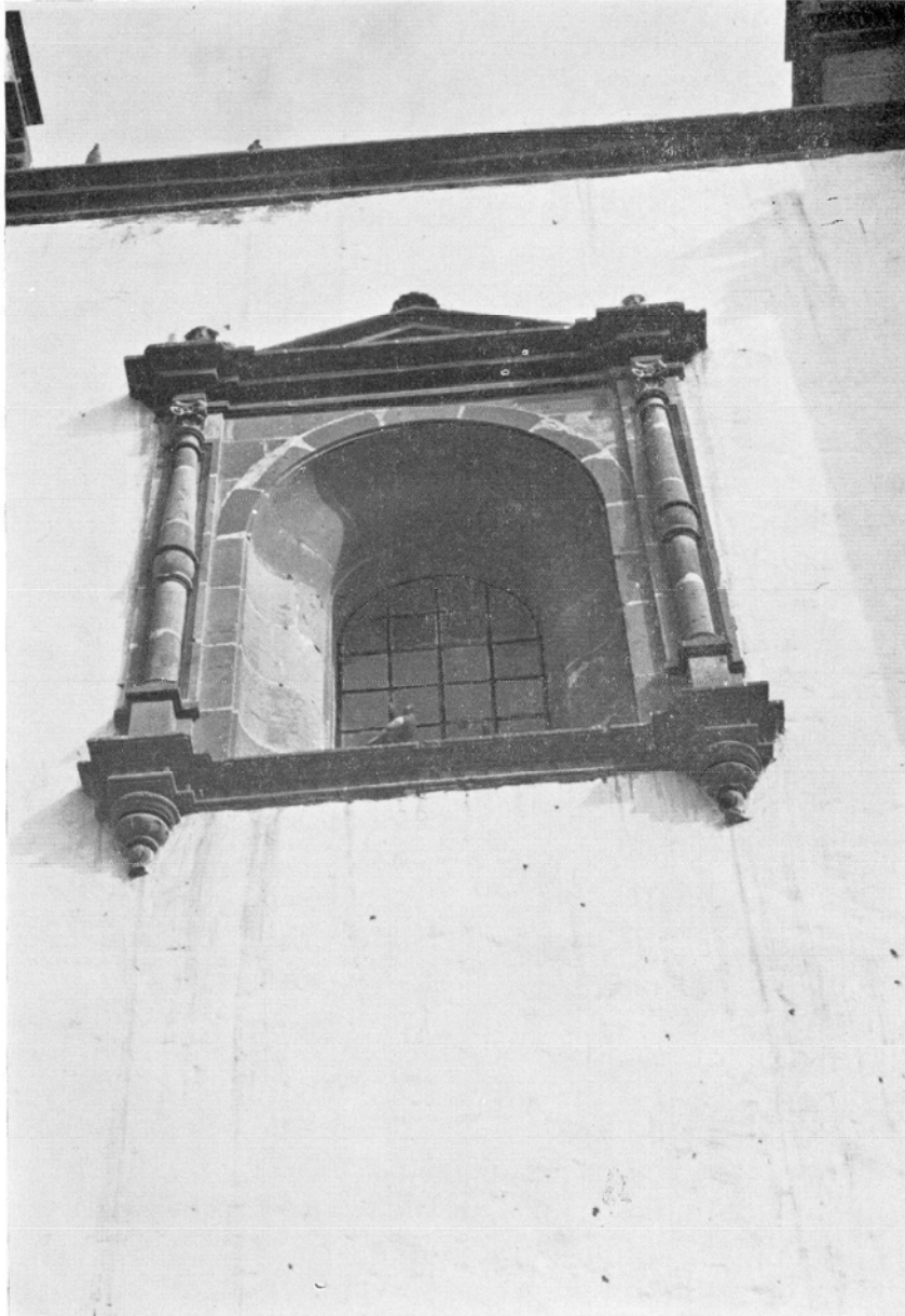
Catedral de Canarias. Ventana de la Capilla de Ntra. Sra. de la Antigua (hoy de Santa Teresa) hacia el Patio de los Naranjos. Obra de Pedro de Narea
