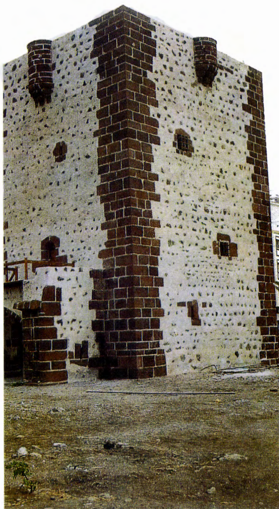
La Torre del Conde, en San Sebastián de la Gomera
