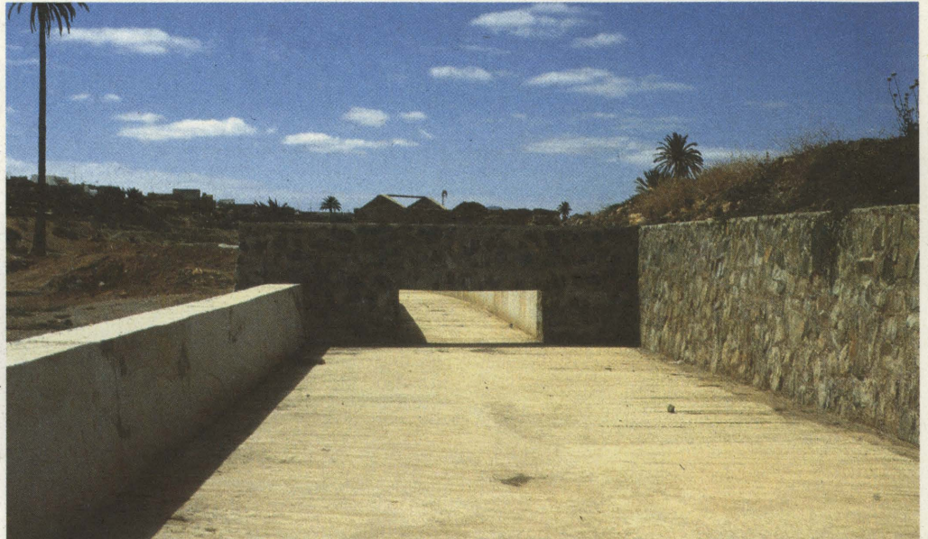
Encauzamiento en el término municipal de Antigua, Fuerteventura.
