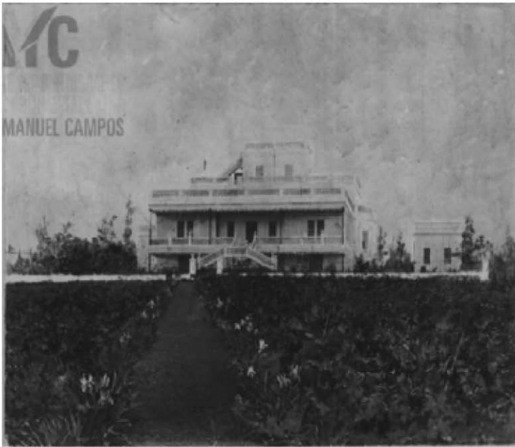
La Tornera recién construida
