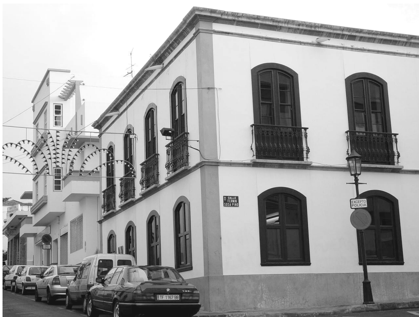
El lugar elegido para albergar el Museo de la Seda es el antiguo inmueble del Ayuntamiento en la calle Manuel Taño
