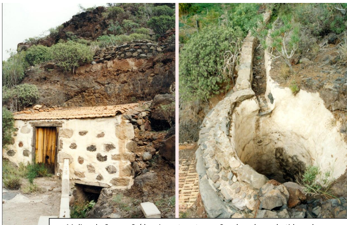
Molino de Cuevas Caídas. Aspecto externo. Canal y cubo embutido en la roca
