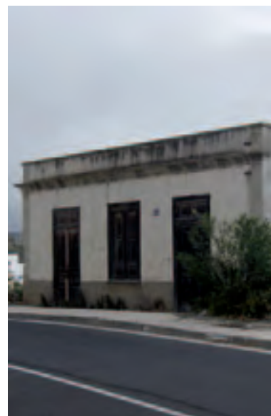
Vivienda alineada a la carretera.
