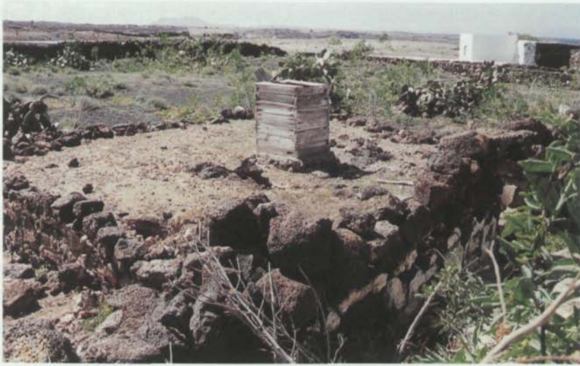
Aljibe cubierto con pared de piedra seca.
