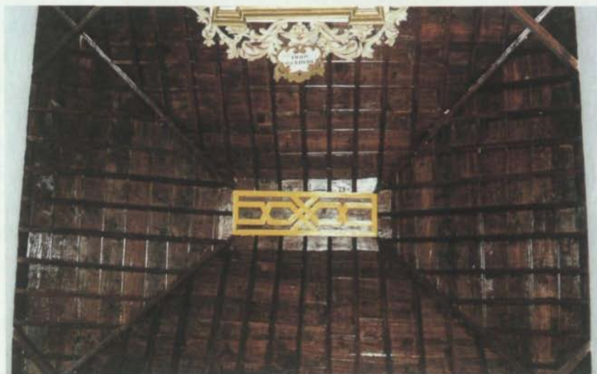
Armadura de la ermita de La Geria.
