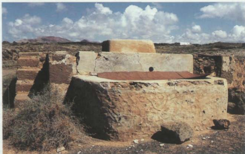
Aljibe cubierto de argamasa.
