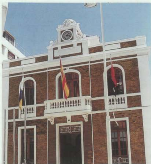
Antiguo edificio del Cabildo Insular de Lanzarote
