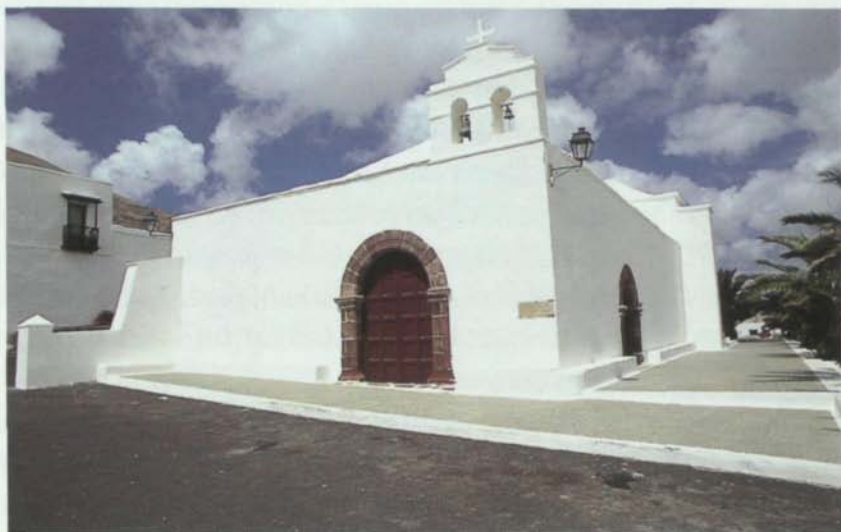
Fachada y lateral de la Iglesia de San Marcial en Femés.
