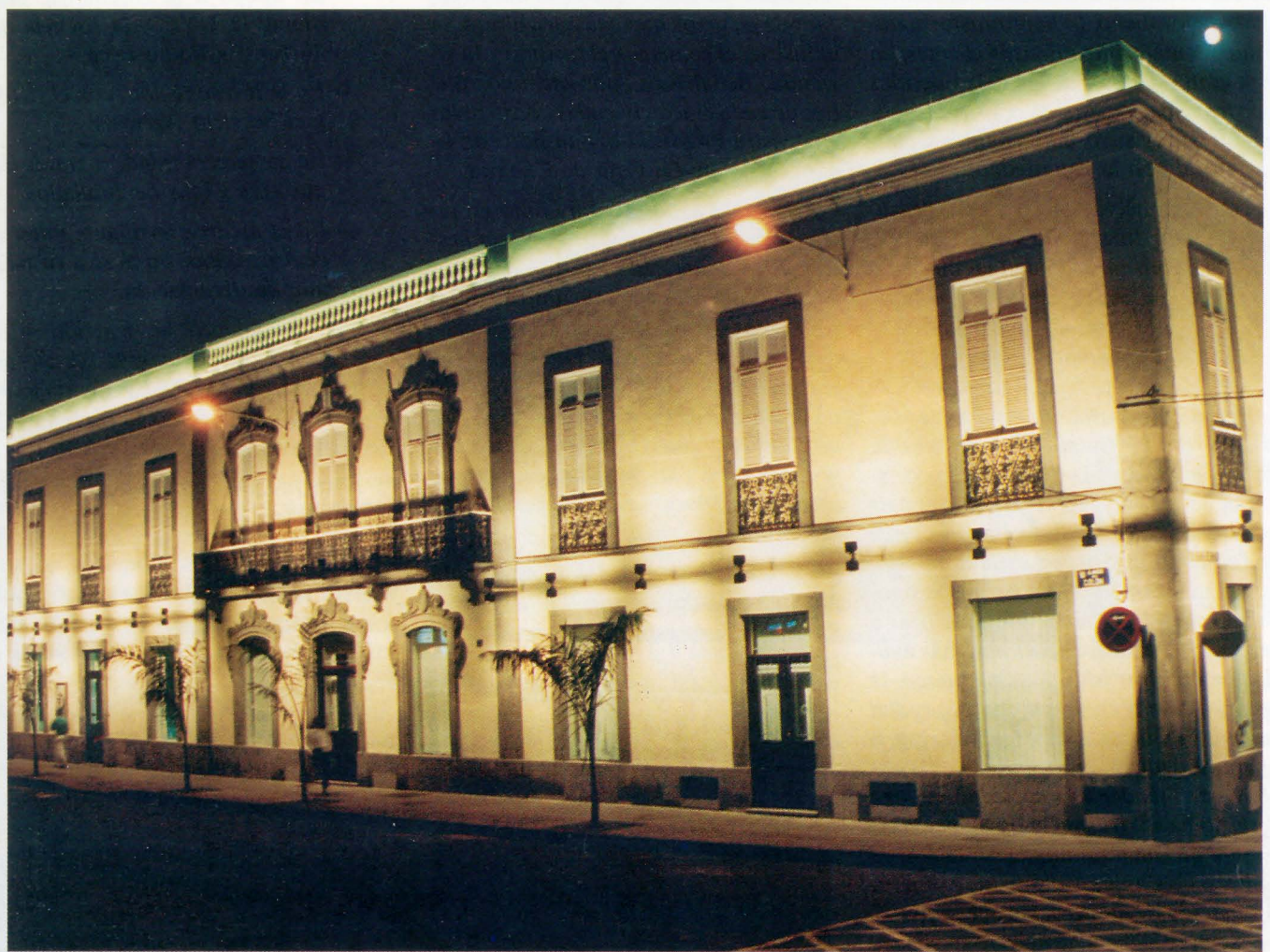
Fachada principal del CICCA, Traza del arquitecto Manuel Ponce de León y Falcón, 1859.
