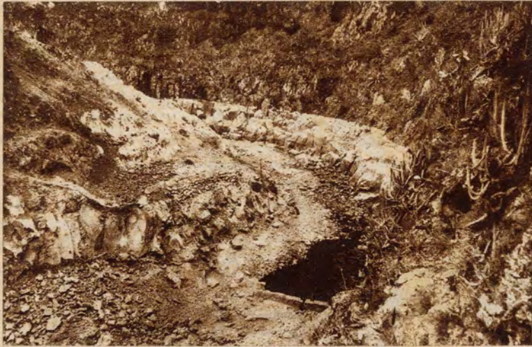
Las primeras aguas que entraron en el embalse se mantuvieron sin pérdida varios meses. Al vaciarlas han dejado en la roca una mancha blanquecina que acusa sobre la piedra el nivel que alcanzaron las primeras aguas que fueron embalsadas
