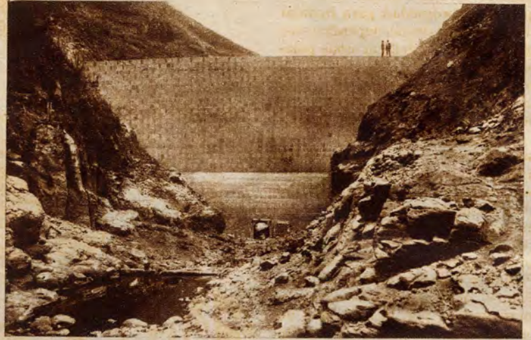
Paramento de aguas arriba de la presa en construcción del Barranco de Lezcano. Sobre los bloques del paramento, en la roca de las márgenes, se observa la mancha blanca que marca el nivel que alcanzaron las primeras aguas embalsadas
