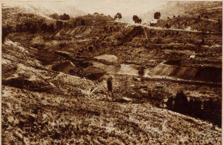
Boca de salida del túnel de evacuación de crecidas, que desemboca en el Barranco del Zapatero
