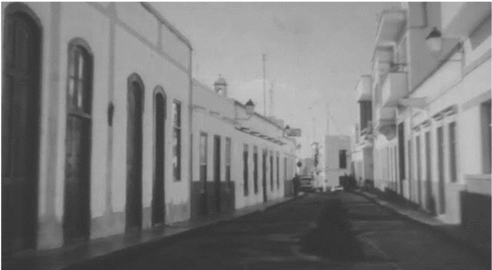
A la izquierda, casa donde sucedieron los hechos antes del derribo.
