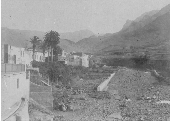
Cauce mucho después del temporal, fabricándose los nuevos muros de contención.
