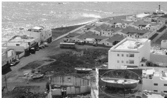
El "inglés" en construcción, 1975.
