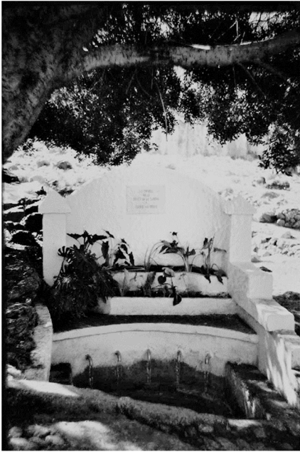
1979, tras una rehabilitación.
