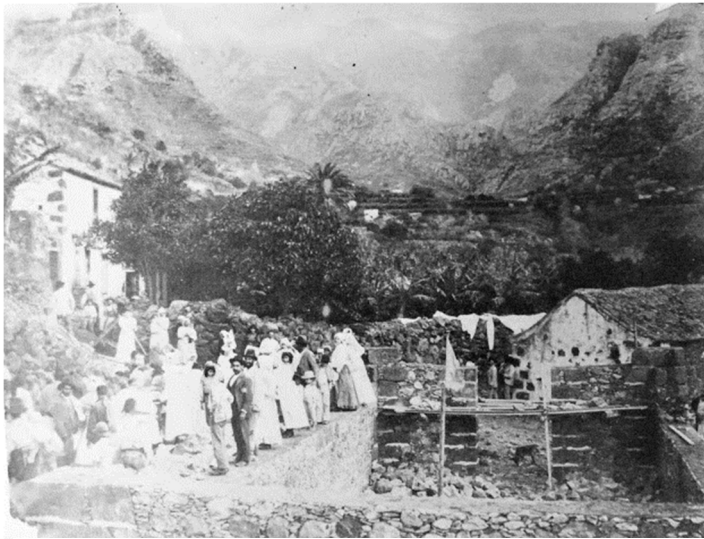
1902, construyendo la ermita.
