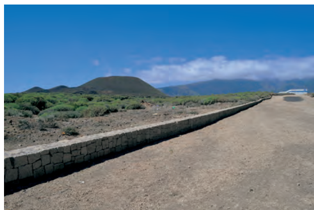
Fotografía 5: Tramo del Camino del Socorro.
