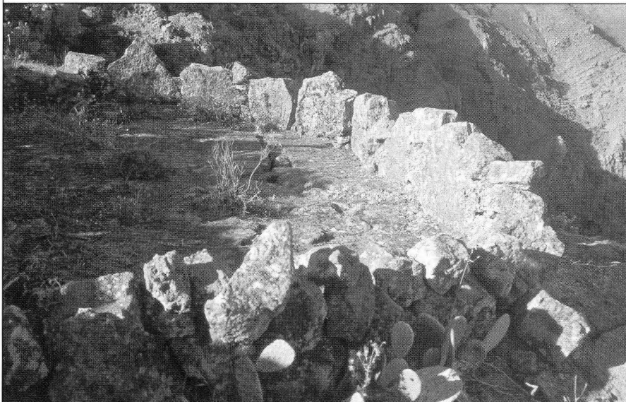
TAGOROR DEL LETIME · Die Nordost-Ecke mit der Bruchspalte
