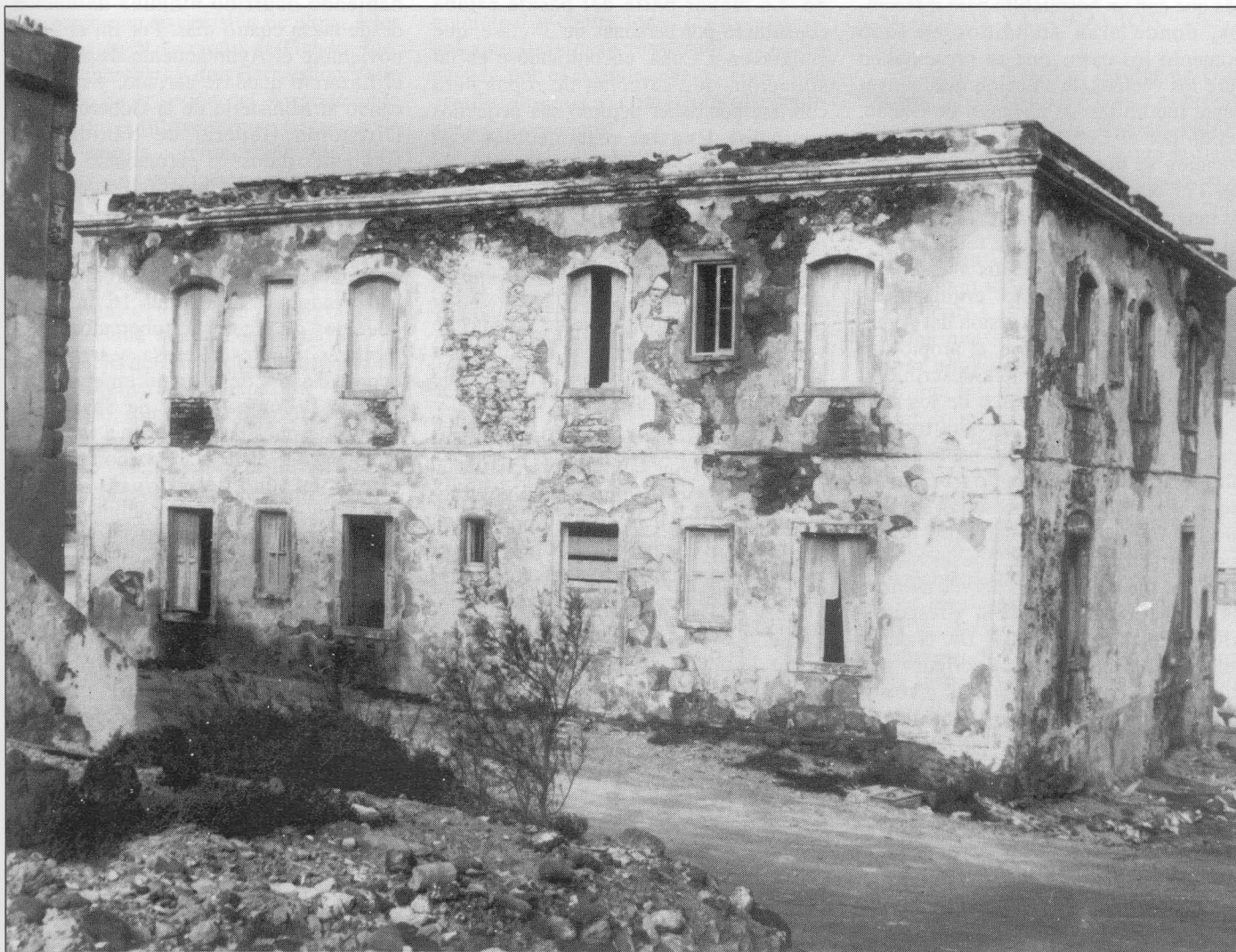
Aspecto actual del Lazareto
