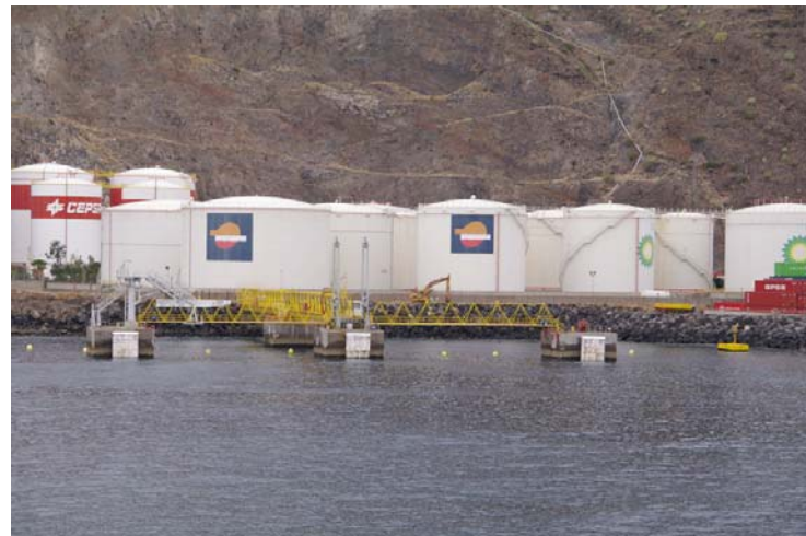
Depósitos de hidrocarburos.
