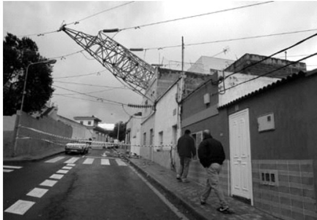
Caída de una torre del tendido eléctrico en Santa Cruz de Tenerife en 2005 . (foto: Reuters)
