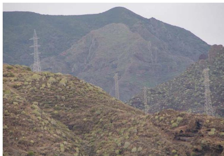
Tendido eléctrico. (foto: J. Martínez)
