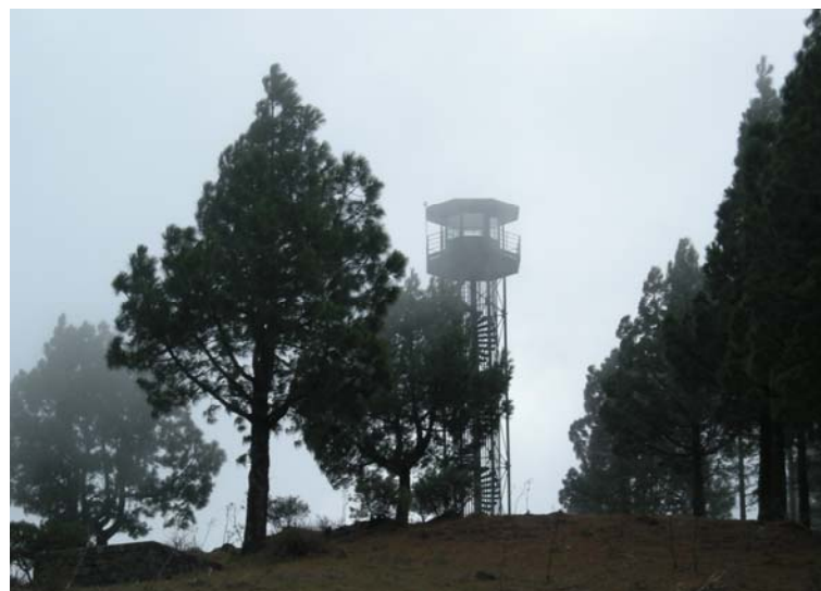
Torre de vigilancia contra incendios
