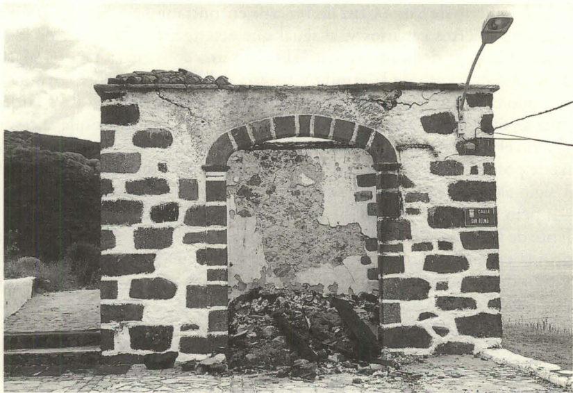
Foto 1. Ermita de San Telmo. Puerto de la Estaca (El Hierro). Ardió en el año 2000. Actualmente restaurada.
