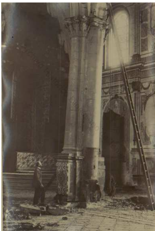
Figura 2. El Ingeniero militar Julio Cervera realizando una inspección para proceder al apeo de la estructura. 5
